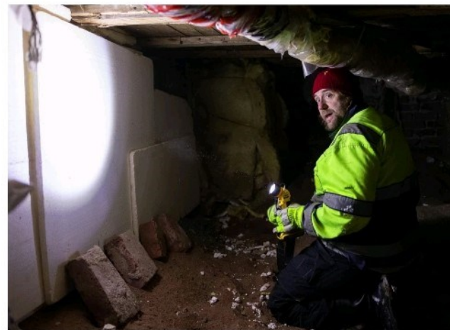
Rakennuskonservaattori Niko Palonen tarkastelee Pirkanmaan maaseudulla sijaitsevan talon alapohjaa ryömintätilassa.
