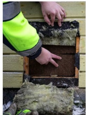
Talon kylkeen tehdään reikä, jotta nähdään, mitä seinien sisällä on.
