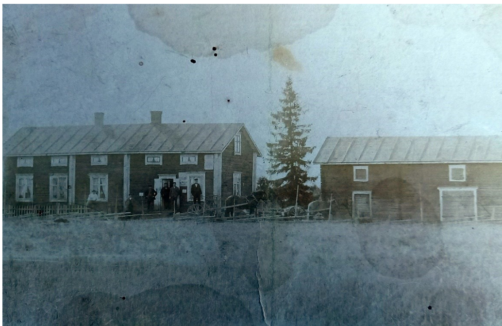
Kuva 25. Vanhin Alppisen kaupparakennuksesta löytynyt kuva (Matti Alppisen kotiarkisto s.a.)
