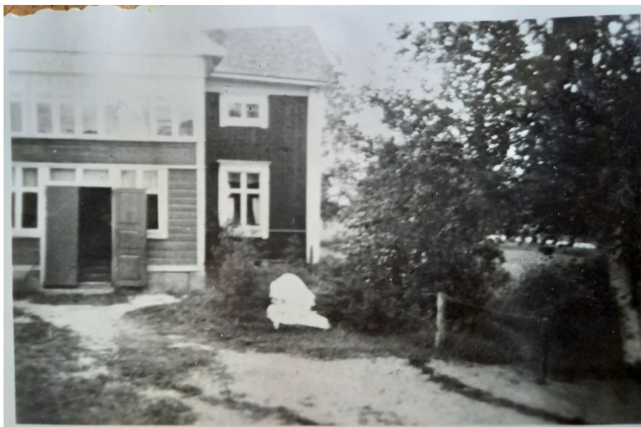
Kuva 16. Huhmarkosken talon julkisivua (Matti Alppisen kotiarkisto s.a.)
