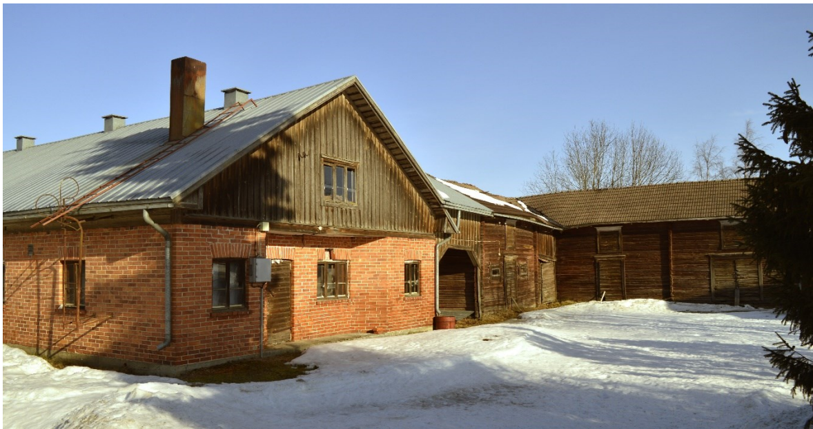
Kuva 21. Huhmarkosken vuonna 1941 valmistunut tiilinavetta vanhan ulkorakennuksen jatkeena (Tapani 2022)
