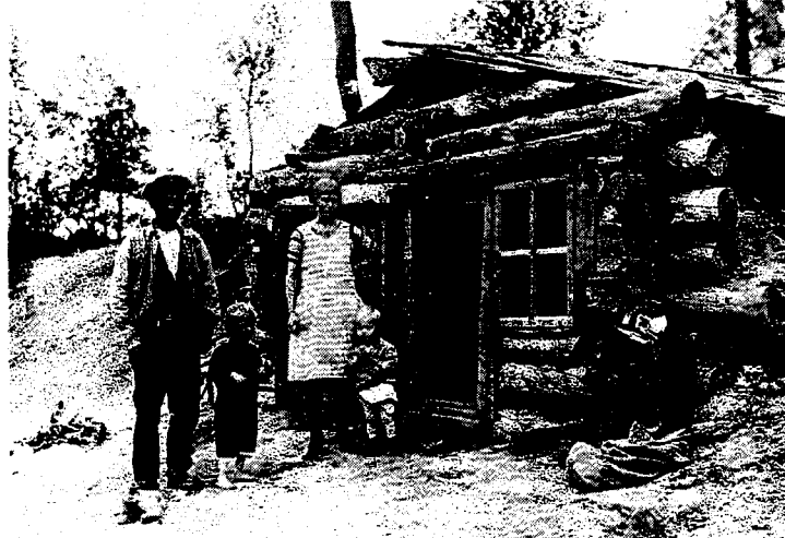
Juho Jauhiainen asui Laukkujoentörmään rakentamassaan maapirtissä (Pä-31 PKU, 40-41 sivujen välissä). Valokuva on havainnollistava esimerkki suomalaisesta uudisasukasperheestä ja heidän asuinrakennuksestaan Suomen Petsamossa.
