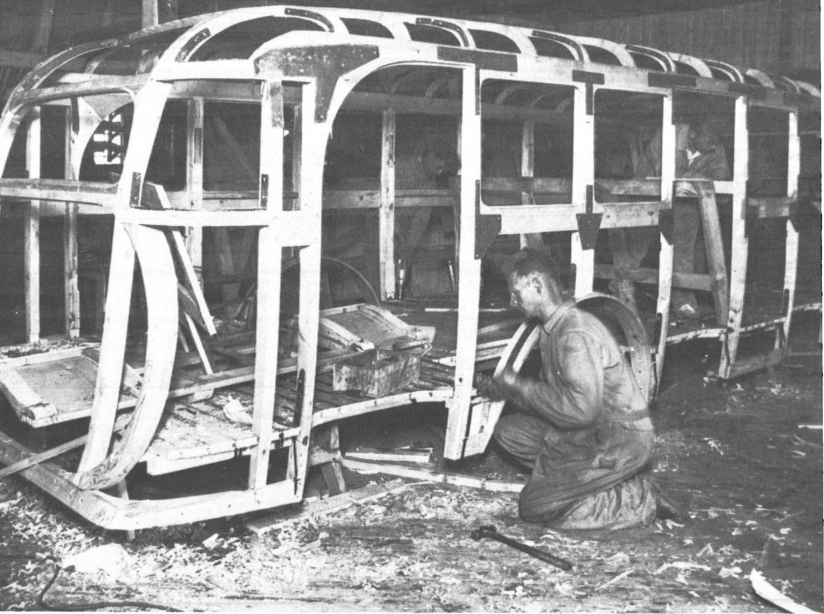
Korin perusrakenteen muodosti pitkään lattian päälle koottu puuristikko, jonka liitokset vahvistettiin niitein tai puuruuvein kiinnitetyllä raudoituksella. Puukehä tervattiin ja päällystettiin teräspellillä. Suurimpana heikkoutena oli korin raskaus ja huonoista liitoksista johtunut riittämätön jäykkyys. Korinvalmistusta 1930-luvulla. LALA.
