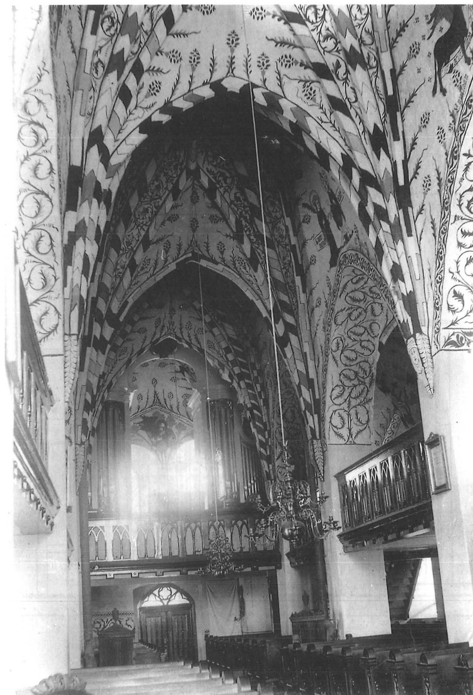
70. Taivassalon kirkko, interiööri länteen vuoden 1890 korjauksen jälkeen. Kuvasta näkee, että lehterien rinta-aidat tehtiin von Heidekenin piirustusten mukaan, vaikka yleisten rakennusten ylihallituksen lausunnon mukaan vanhat piti mahdollisimman pitkälle säästää.
