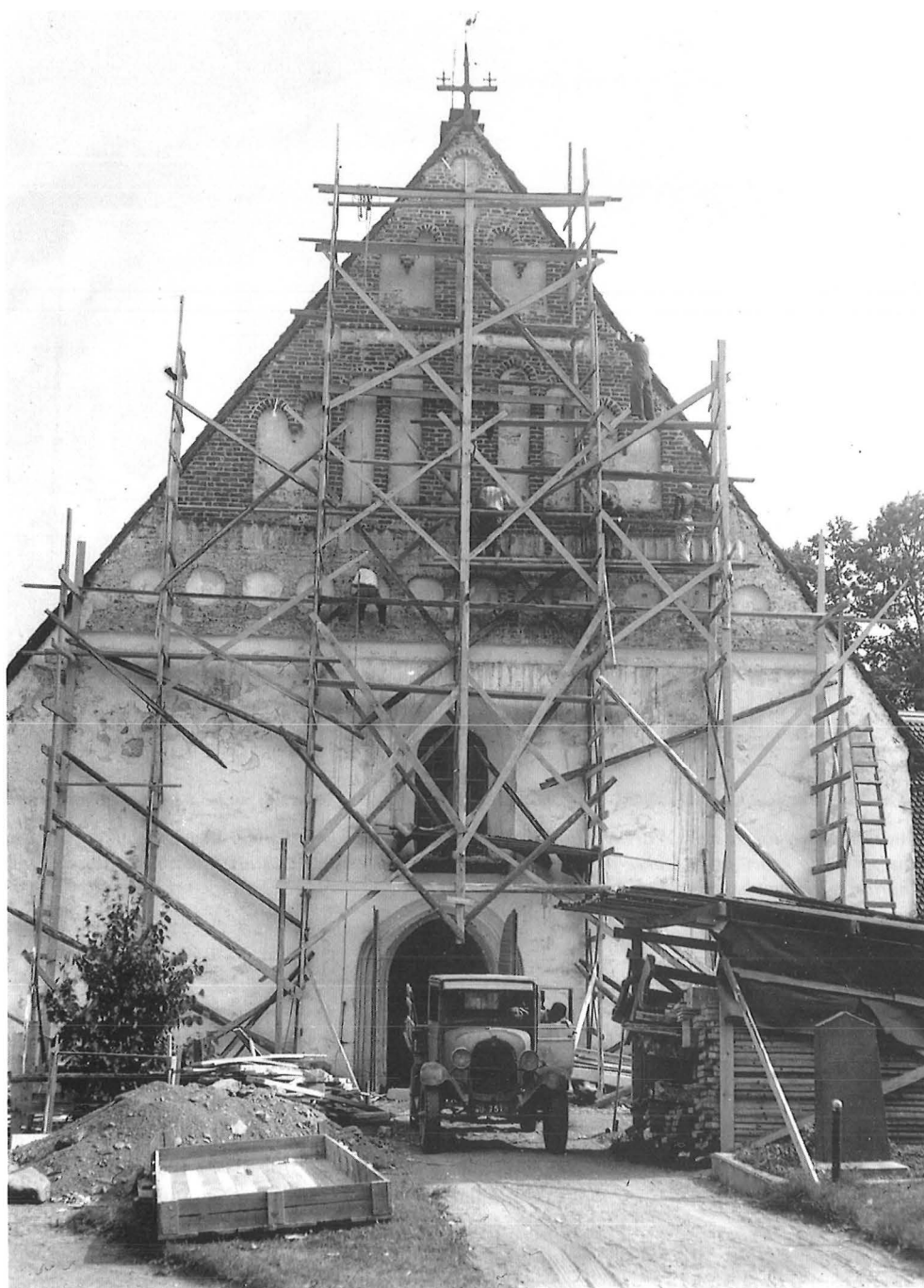
26. Valkoiseksi rapatun Peräjämäen kirkon tiilipäätyjen rappaus hakattiin alas vuonna 1938.
