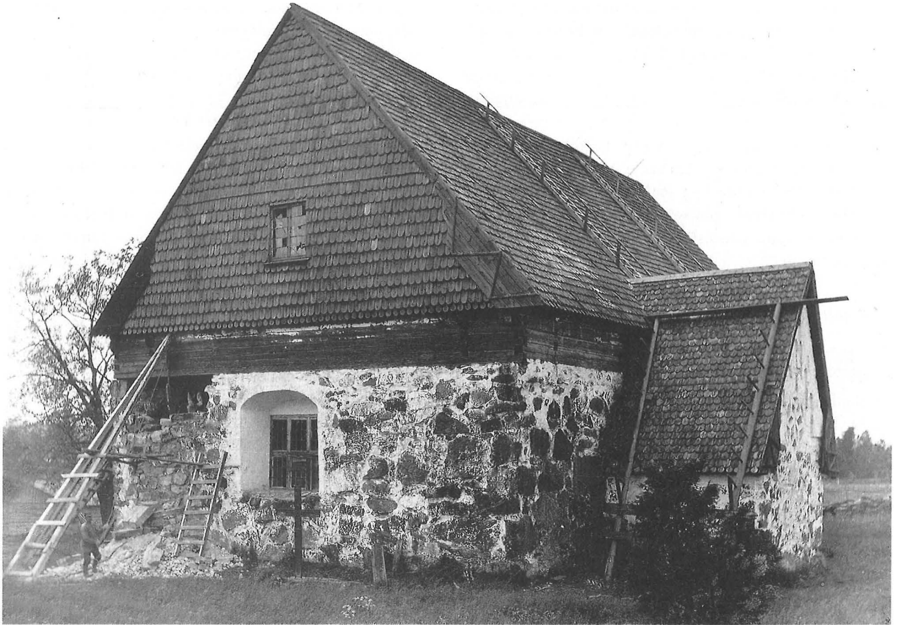
53. Messukylän vanha kirkko, murtunutta koillisnurkkaa puretaan vuonna 1907. Kuva on Carl Frankenhaeuserin.
