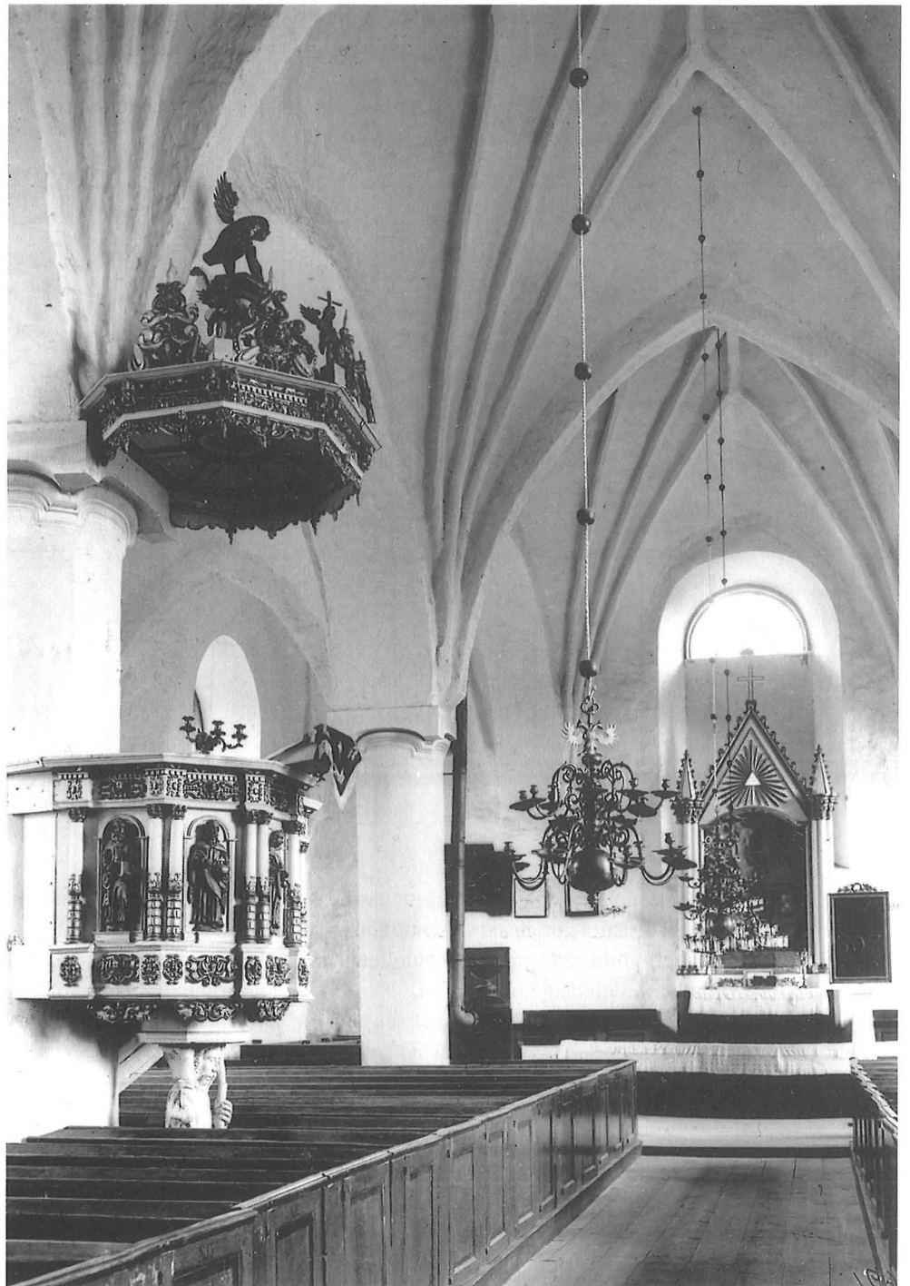
24. Siuntion kirkon interiööri alttarille päin. Kirkko paloi vuonna 1823. Sen jälkeen tehdyssä korjauksessa mm. purettiin sakaristo ja asehuone sekä pilarit pyöristettiin. Kuvan on ottanut K. K. Meinander vuonna 1909.
