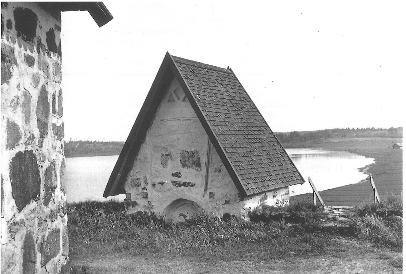
19. Karjaan kirkkomaan porttirakennus on jäänyt kirkon puolelta osittain maan alle siten, että kulku on järjestetty puuportaita myöten. Maanpinta on joko vuosisatojen kuluessa itseksään kohonnut karttuvasta eloperäisestä aineksesta, tai sitten kirkkomaalle on ajettu lisämaata, jotta hautauksia voitaisiin jatkaa. Kuvan otti Carl Frankenhaeuser vuonna 1907.
