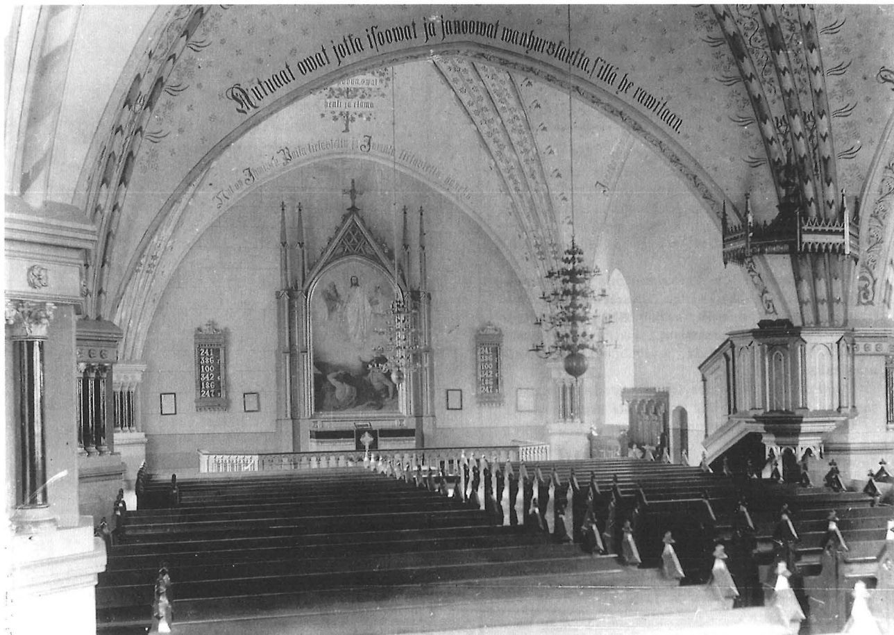
73. Huittisten kirkko, interiööri alttarille päin Stenbäckin suunnittelemien korjauksen jälkeen vuonna 1897. Oikealla näkyy Stenbäckin suunnittelema pappien penkki. Saarnatuoli ja alttarilaitte jäivät jäljelle von Heidekenin 1870-luvulla suunnittelema korjauksesta. Alttaritauluna on Severin Falkmanin vuonna 1878 maalaama Kristuksen kirkastus. Huomioi nurkkapilarien muotoilu, niiden tummat kiiltäviksi käsitellyt kolonnetit sekä kaikkien seinä- ja holvipintojen maalauskoristelu.
