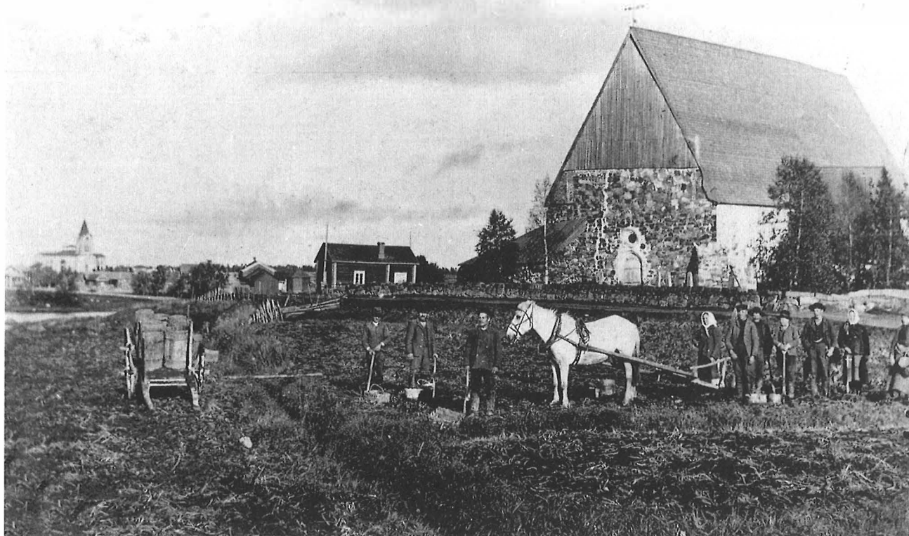
16. Perunannostajia Isonkyrön vanhan kirkon edustalla vuonna 1911. Taustalla näkyy vuonna 1878 rakennettu uusi kirkko. Vanhan kirkon päädyt purettiin vuonna 1820 koska niiden pelättiin sortuvan.
