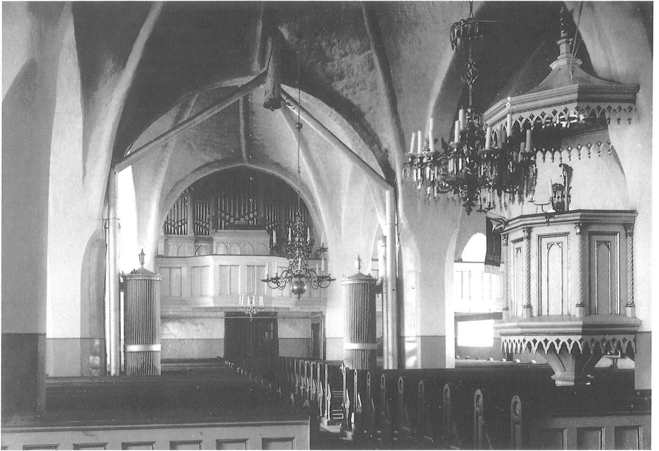
22. Pertelin kirkossa korkeat ripaunut ja usean mutkan tekevät savutorvet muodostivat varsin suuren rakennelman. Ensimmäiset uunit hankittiin vuoden 1888 korjauksen yhteydessä. Samana vuonna myös pilareita viistottiin, jotta kirkkoon saataisiin mahtumaan lisää penkkejä. Kuva on vuodelta 1933.
