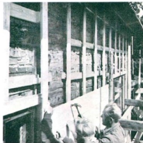
Vanha lautavuoraus poistettiin ja seinä oikaistiin lautarimoituksella. Pystysaumat tiivistetään huopakaitoilla ja vaakasaumoissa levyt liimittävät 6 cm päällekkäin. Kiinnitys tapahtuu nauhaamalla.
