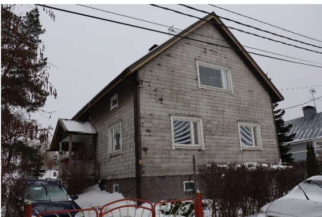
Kuvat 10, 11. Kuvien rakennuksessa asbestisementtilevy on todennäköisesti alkuperäinen julkisivumateriaali (KRJ).
