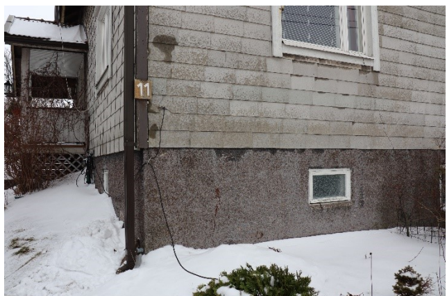
Kuvat 10, 11. Kuvien rakennuksessa asbestisementtilevy on todennäköisesti alkuperäinen julkisivumateriaali (KRJ).
