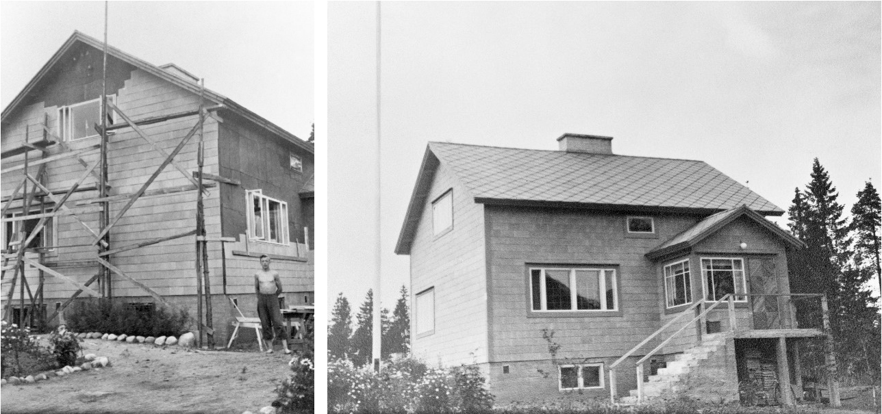
Kuvat 19, 20. Rakennusaikaisista valokuvista voi päätellä Minerit-levyjen olevan rakennuksen alkuperäinen julkisivumateriaali.
