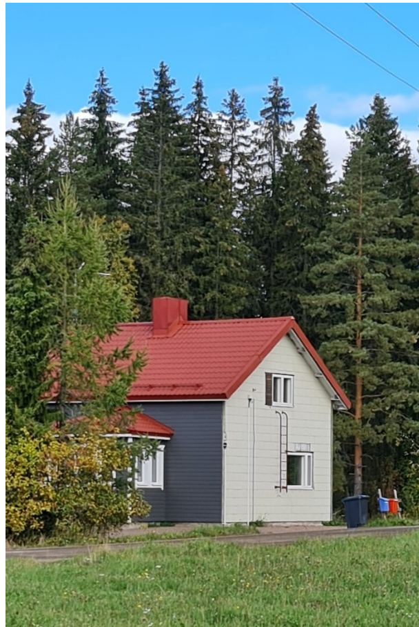
Tämä ajan ja merituulien tuivertama rakennus vuorattiin 25x120 cm:n Minerit-seinälevyillä.
