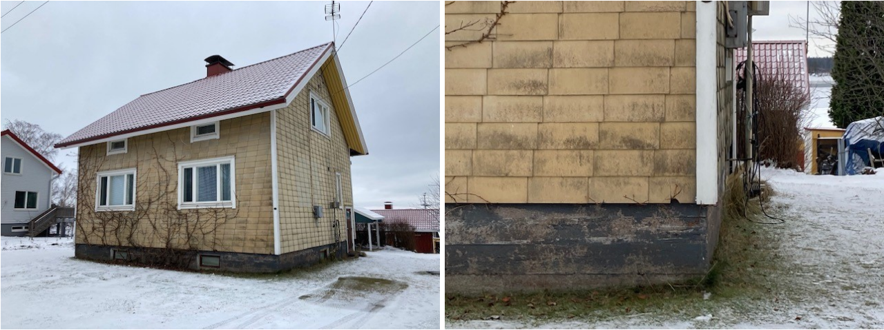
Kuvat 4, 5. Rakennuksen julkisivuverhous on toteutettu 25% limityksellä (KRJ).
