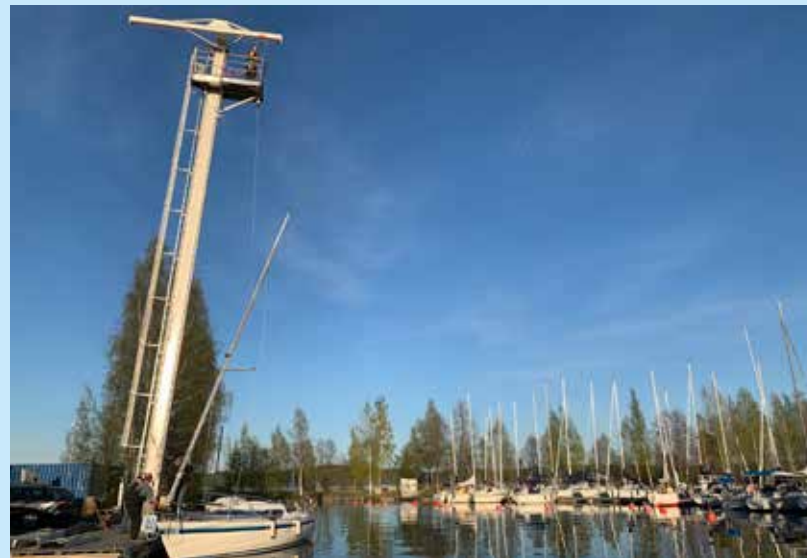
Samppa J. Salmisen ja Timo Siltalan insinööritaidot pääsivät esille mastonosturin suunnittelussa, projektinhallinnassa ja käytännön ratkaisussa. Tonniain painoinen pylväkääntyi rakennustyön aikana yhden miehen voimin.
