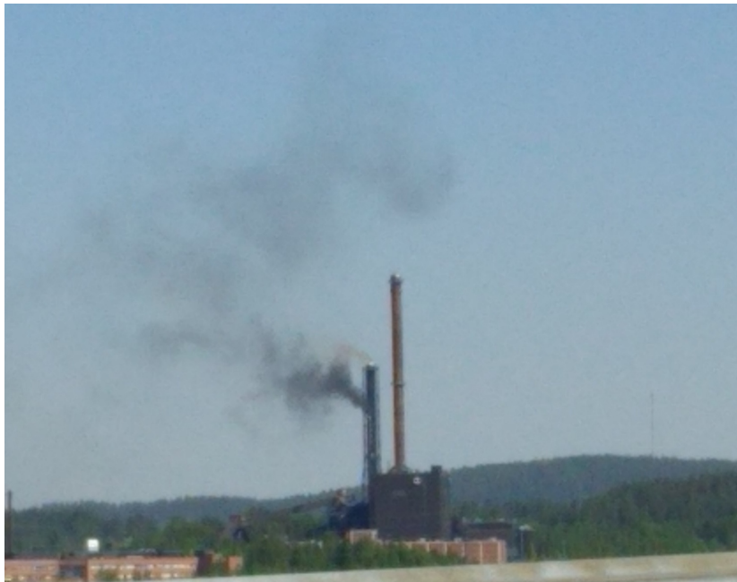
Kuva 2.1: Aistein havaittavia haitta-aineita poltovoimalaitoksen savukaasuisa, kun savukaasunpuhdistuslaitteistot ovat toimintahäiriön takia hetkellisesti poissa käytöstä.
