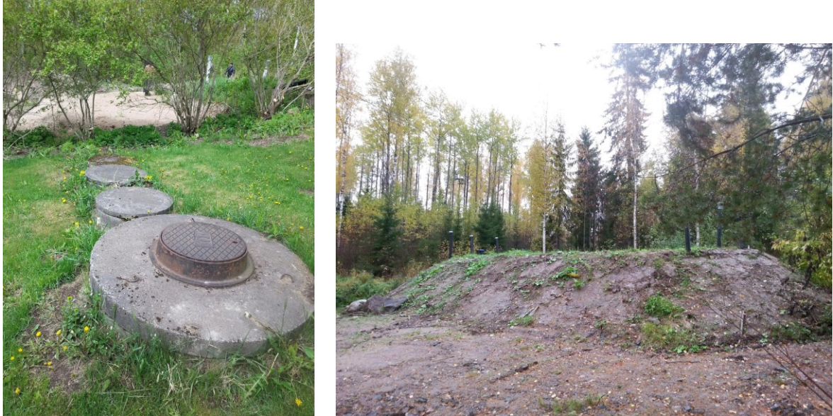
Kuva 5. Nurmijärven 3-osainen saostussäiliö ja maasuodattamo, (Kuva: Linda Mutanen 2017)
