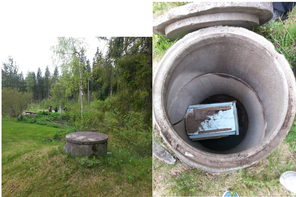
Kuva 20. Nurmijärven porakaivo ja kaivon yläpuoliset rakenteet. (Kuva: Linda Mutanen 2017)
