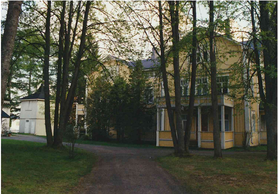
Kuva 16. Luostarin kartanorakennus kunniapihan puolelta. Kuvassa takana kanadantuijat, jotka poistettiin 2000-luvun alussa.
