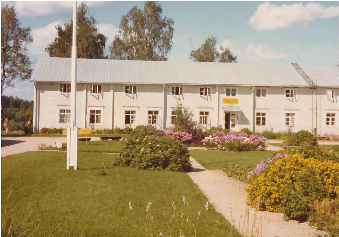
Kuva 24. Entinen työpiha 1980-luvun alussa. Jaakko Wegeliuksen suunnitelman mukaiset käytävät ovat olemassa. Kuvassa näkyy erilaisia syysleimuja, kurtulehtiruusuja ja keltaista pensashikkia.
