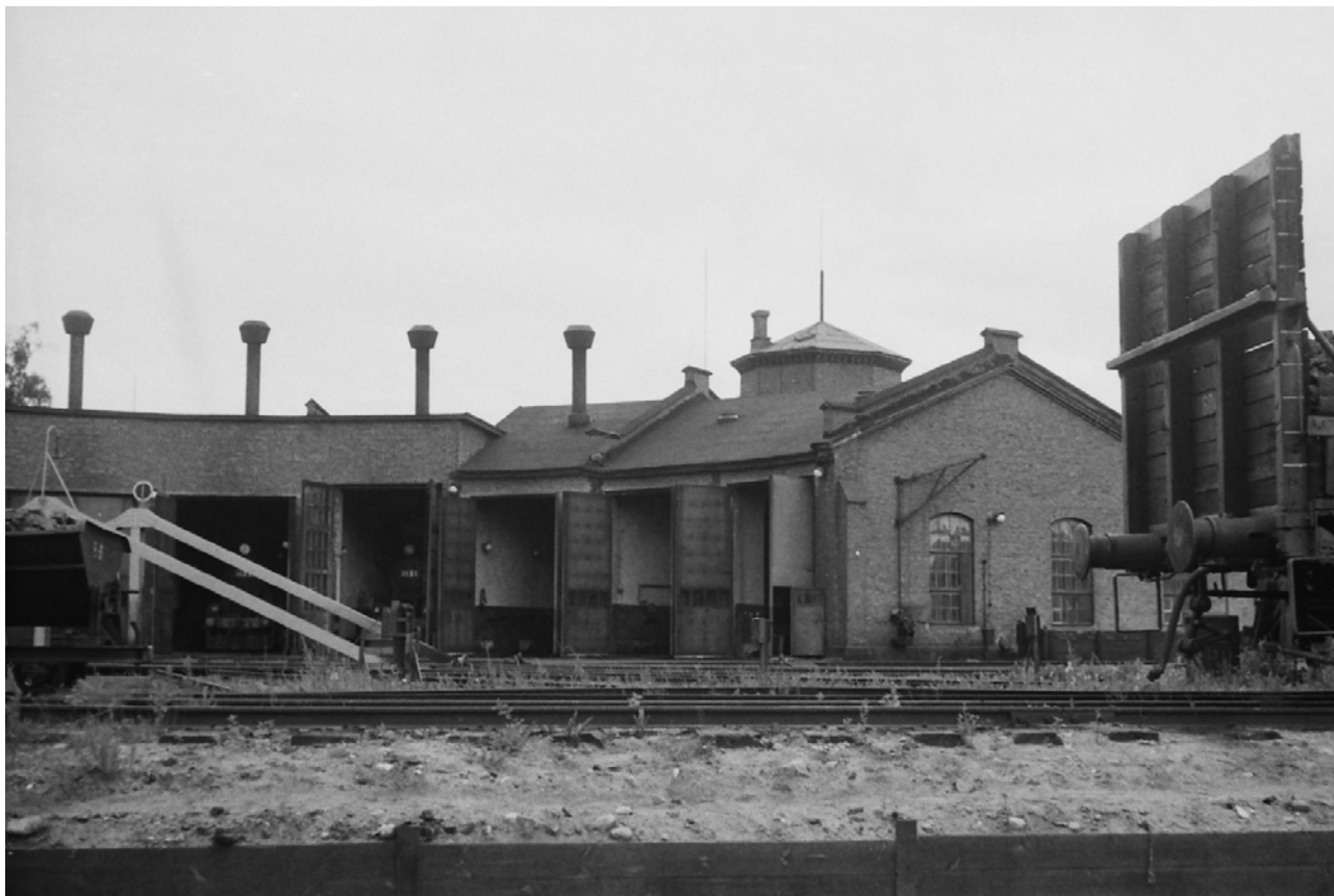
Kuvat: Tapio Keränen, Jyväskylän Veturitali 22.7.1968. Savutorvet ovat paikallaan talleja 1-2 lukuun ottamatta. Savutorvien tehtävä oli ohjata höyryveturin tuottama savu ulos talleista. Talli 1:n sivuseinällä on havaittavissa siinä vieläkin paikallaan oleva kevyt nosturi. Vanhimman päädyn räystäskoristelu on myös kuvassa nähtävillä.
