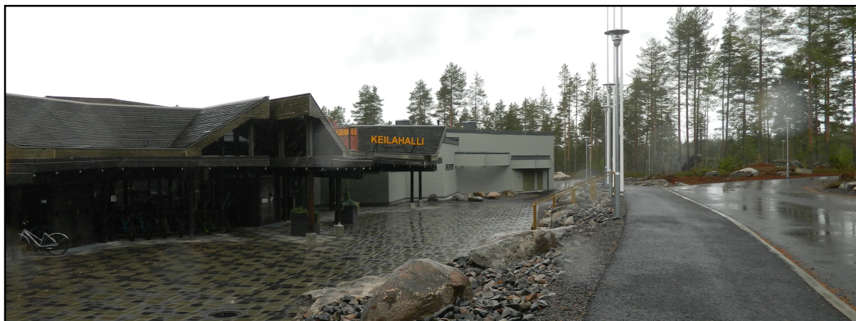
KUVA 17: UUSI KEILAHALLILAAJENNUS EROTTUU AINAKIN VÄRINSÄ VUOKSI HOTELLIN VANHEMMISTA OSISTA. RAKENNUSMASSAAN SE TUO MELKO SUUREN LISÄN.
