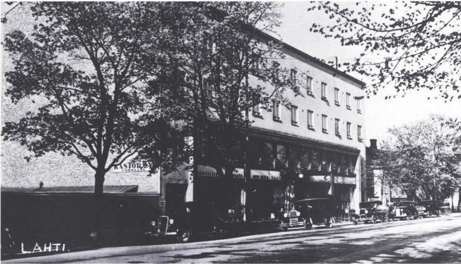
Seurahuoneen talo ennen korottamista.
