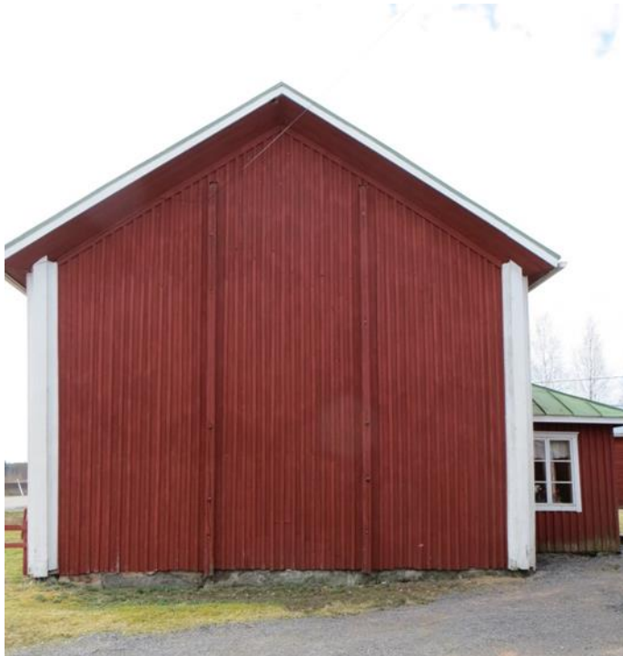
Kuva 4 Pohjalaistalon hirsiseinärakennetta tukee föjjarit. Kuva: Marika Kokko
