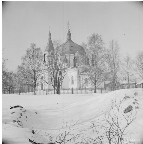
Sortavalan kreikkalaiskatolisen seurakunnan kirkko Suomen ja Neuvostoliiton välisen talvisodan päättymisen jälkeen maaliskuussa 1940. Alueluovutusten jälkeen Sortavalan seurakuntaa jatkamaan perustettiin Jyväskylän ortodoksinen seurakunta vuoden 1950 alussa. Ennen sotia Sortavala oli Suomen ortodoksisen kirkkokunnan virallinen keskus vuodesta 1925 alkaen. Myös ortodoksinen pappisseminaari sijoittui Sortavalaan jo vuonna 1918. Lähde: SA-kuva
