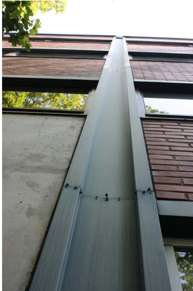
Hallintorakennuksen julkisivupellys keväältä 2011.
