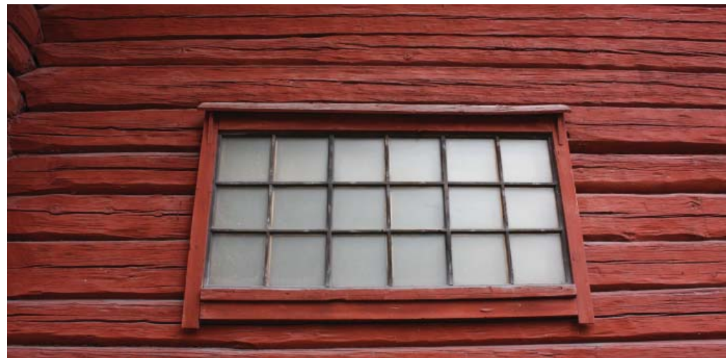
Riihen itäisen seinän suuri ruutuikkuna. Kuva: Majju Nurminen 2013 JYM.
