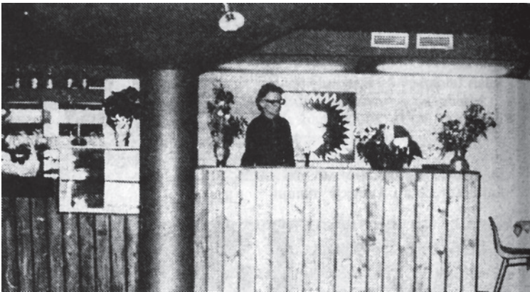
Kuva 26. Ravintola Sunriseksi muuttuneen diskon tilat kävivät läpi mittavan remontin. Myyntitiskin viereen tehtiin tiskijukalle uusi työtila, jossa kuvassa seisoo ravintolan vastuunalainen hoitaja Kåre Larsen. Kotkansilmä 15.12.1977.
