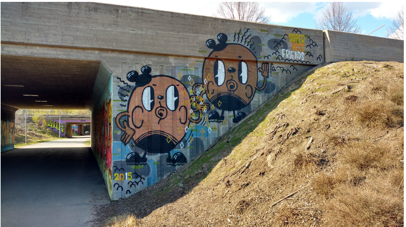
Kuva 11. Kevyenliikenteen alikulkutunneli, Rantaväylä. (Kuvaaja Pekka Kanerva 2016).
