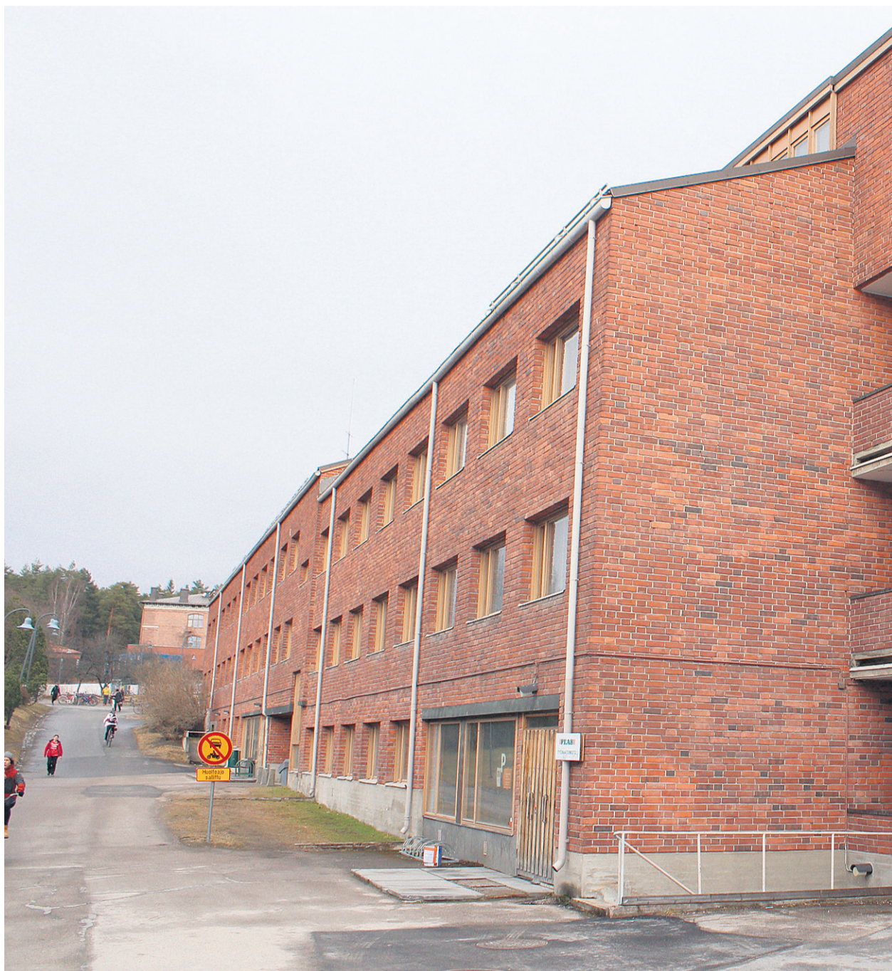
Jyväskylän yliopiston rakenneuudistuksen myötä muun muassa kielten ja viestinnän laitokset yhdistetään. Kielten laitoksena toiminut P-rakennus on tällä hetkellä remontissa.
