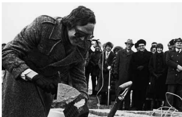
Opetusministeri Kalevi Kivistö muuraamassa Mattilanniemen toisen rakennusvaiheen peruskiveä vuonna 1979. (Kuva: tiedekunnan arkisto)
