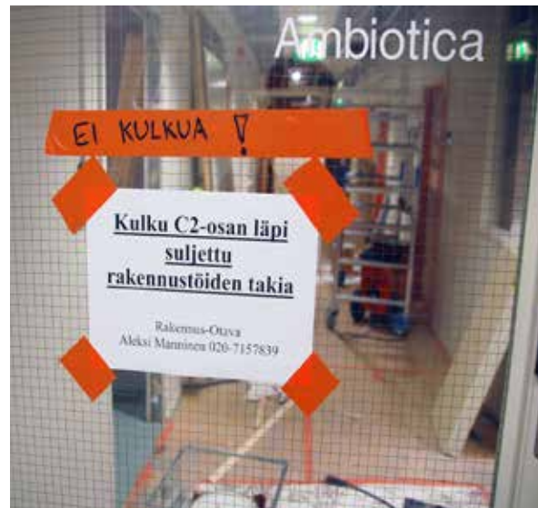
Kuva kertoo 2000-luvun rakentamisen laadusta. Ambiotican vihkiäisiä vietettiin 3.9.1999, ja jo ennen kuvassa näkyvää suurta remonttia oli ilmennyt yhtä ja toista epäilyttäviä. (Kuva: Paavo Niutanen)
