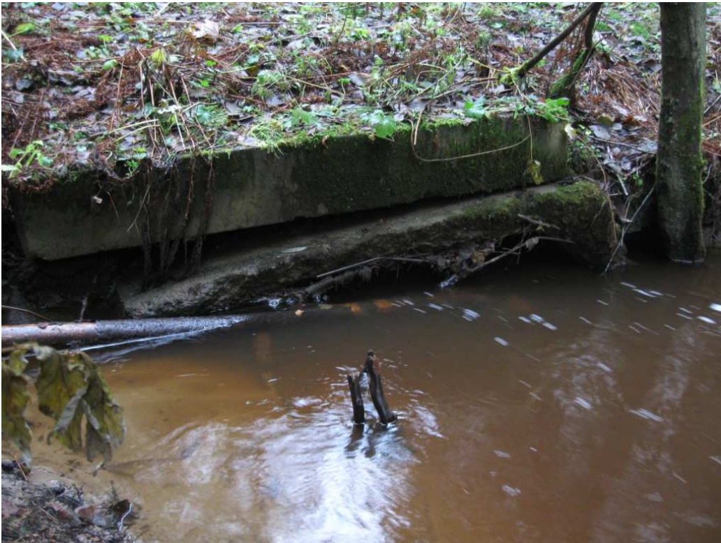
Kuva 11. Keljonpuron tierumpujen yläosa.
