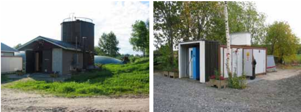
Kuva 9.1. Kalmarin tilan 150 \text{ m}^3 :n biokaasulaitos (vasen kuva) ja biokaasun jalostusyksikkö ja tankkauspiste (oikea kuva) Laukaassa (kuva: Annimari Lehtomäki).
