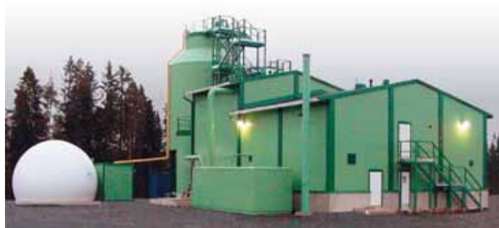
Kuva 9.4. Laihian kunnan biokaasulaitos (kuva: Teuvo Rajamäki).
