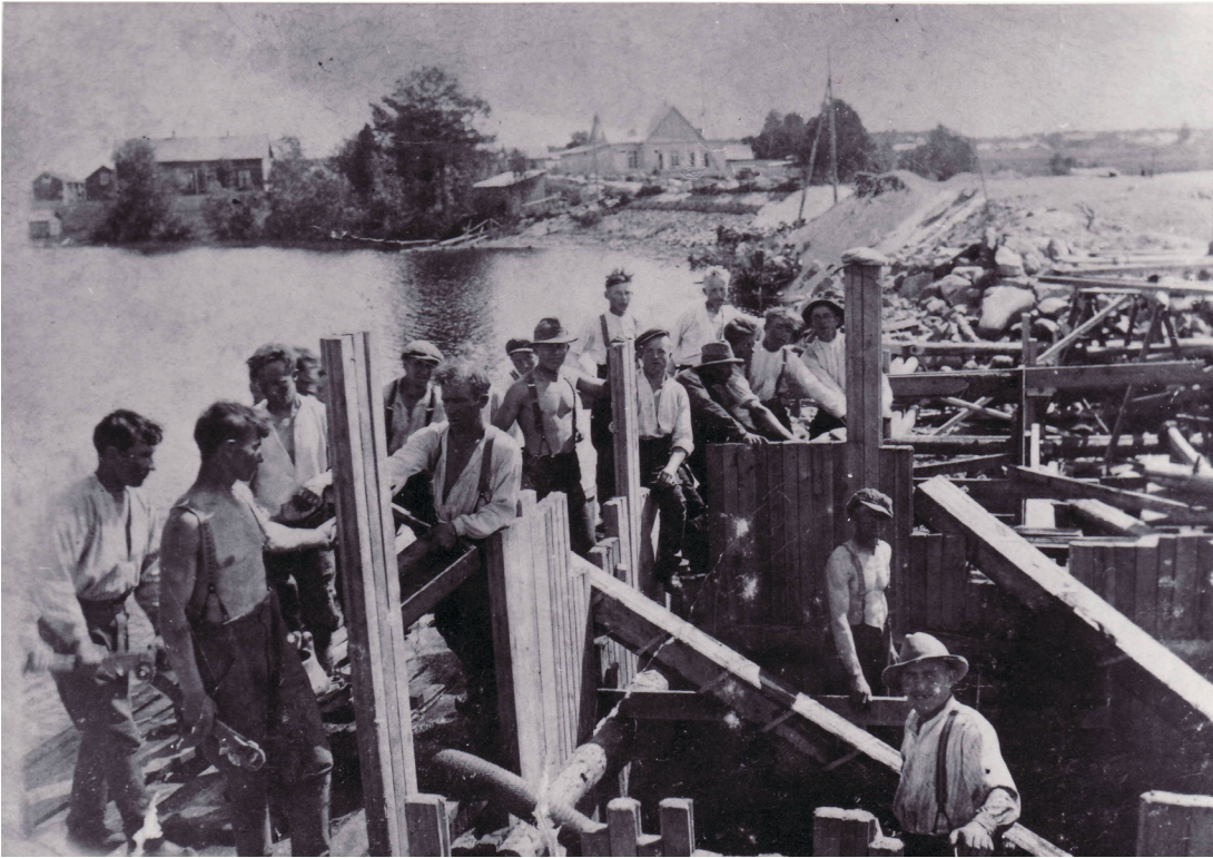
KUVA 4. Ylä-Jäpän ja Savijärven välisen salmen ylittänyt puusilta korvattiin vuonna 1932 kivisillalla (Talvisto 1999, 145). Kuvassa on sillan rakennusporkkaa vuonna 1932. Taustalla vasemmalla näkyy
