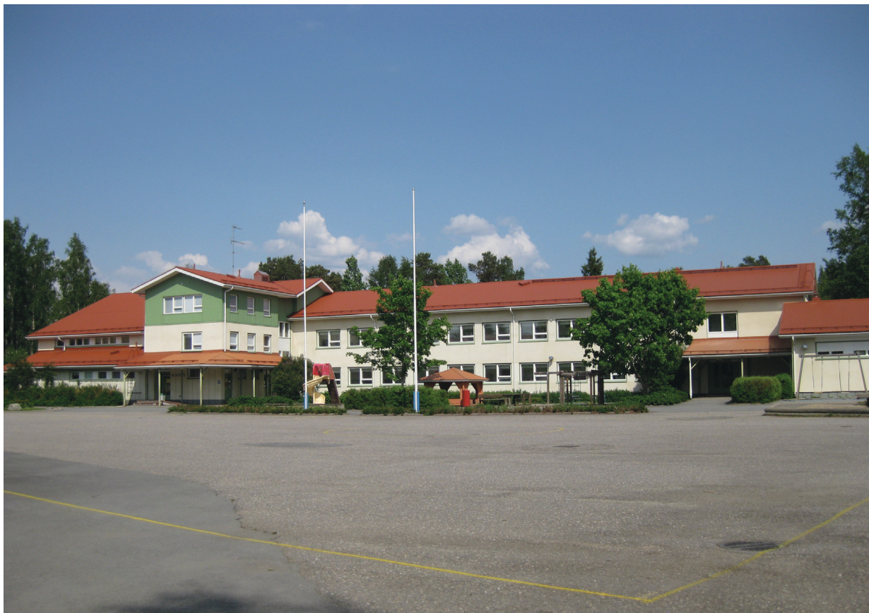
KUVA 41. Kinnulan kansakoulu, nykyinen ala-aste rakennettiin vuonna 1970. Valokuvan mukaiseen asuun alun perin tasakattoinen rakennus muuttui vuoden 1996 peruskorjauksessa. (KSM-KIOSKI_207053.) Kuvaaja: Nina Moilanen, 2013. Keski-Suomen museon kuva-arkisto.
