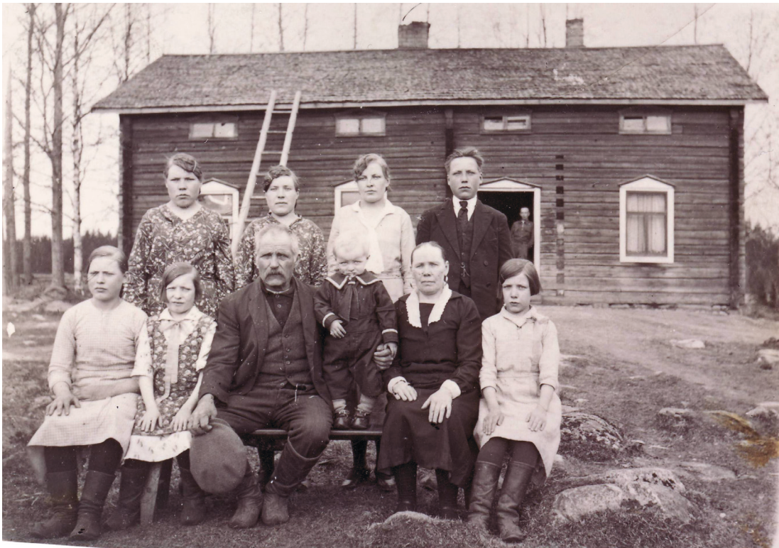
KUVA 5. Kuvassa oleva Pihlajakosken talo edustaa Kinnulassa melko yleistä rakennustyyppiä, jossa porstuan toisella puolella on tupa ja toisella pienempi kamari tai pari. Rakennus on pitkänurkkainen ja vuoraamaton. Räystäään alla olevat
