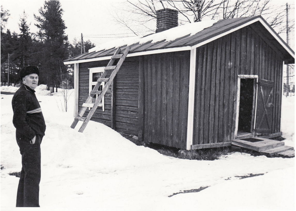
KUVA 10. Suutari Ilmari Storck mökkinsä edustalla. Suutari Storckin mökki oli tyypillinen maaseudun tilattoman väen mäkitupa-asumus, jossa oli tupa ja lautarakenteinen eteinen. Rakennus on siirretty Kinnulan kotiseutumuseon pihapiiriin 1980-luvulla (KSM-KIOSKI_206683). Kuvaaja: Aulis Urpilainen. Hellin Urpilaisen valokuvakokoelma.
