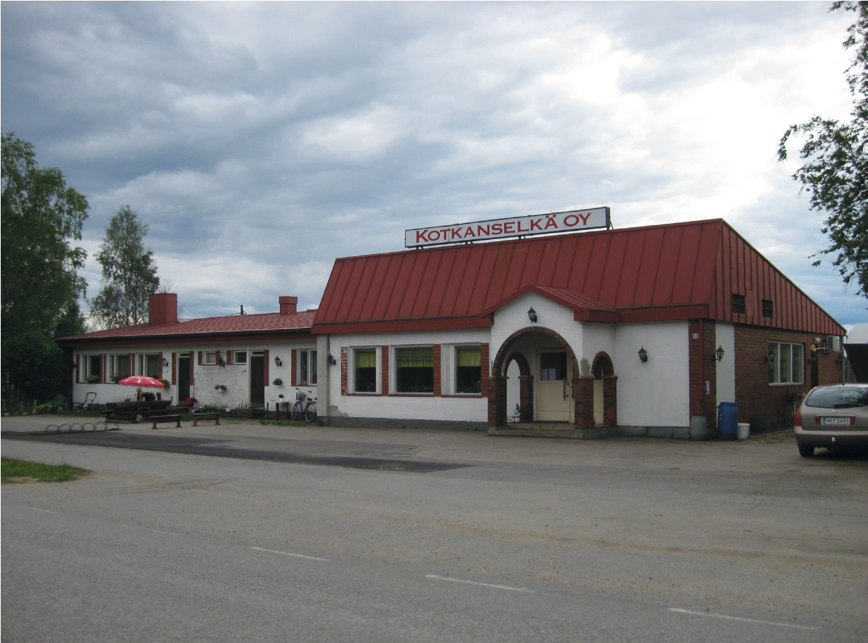
KUVA 34. Paavo Tiaisen vuonna 1964 rakennuttama liike- ja asuinrakennus on saanut ylleen 1980-luvulla espanjalaishenkisiä yksityiskohtia (KSM-KIOSKI_207071). Kuvaaja: Nina Moilanen, 2013. Keski-Suomen museon kuva-arkisto.
