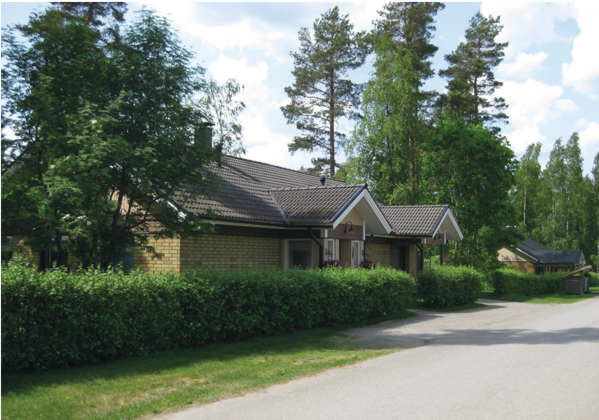
KUVA 28. 1970- ja 1980-luvun pientaloissa Kinnulassa tiili on yleisin julkisivumateriaali. Alun perin tasakattoisten talojen kattomuoto on miltei kaikissa taloissa myöhemmin muutettu harja- tai aumakatoksi. Kuvassa 1970-luvun tiilitaloja Kallentiellä. Kuvaaja: Nina Moilanen, 2013. Keski-Suomen museon kuva-arkisto.
