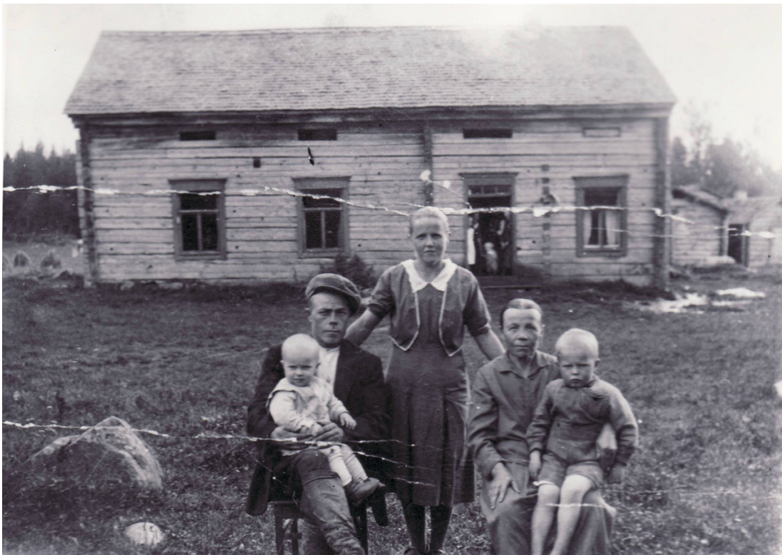
KUVA 6. Sammallahden talo on toinen esimerkki tyypillisestä kinnulalaisesta talosta pitkänurkkasalvoksineen ja haukkaikkunoineen. Rakennus on pohjaltaan epäsymmetrinen paritupa. Valokuva on
