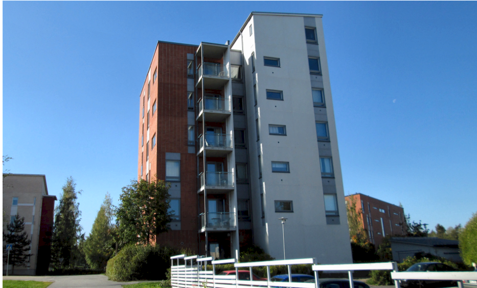
Kuva 15: Ainolankaari ja rakennuksen lähiympäristö Lehtorannantieltä kuvattuna
