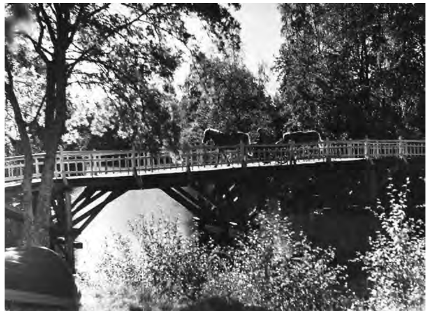
Kuva 19. Kuvassa on useita kertoja korjattu ja uusittu Mustansalmensilta ennen vuotta 1973, jolloin se korvattiin betonisella maantiesillalla. PPM.
