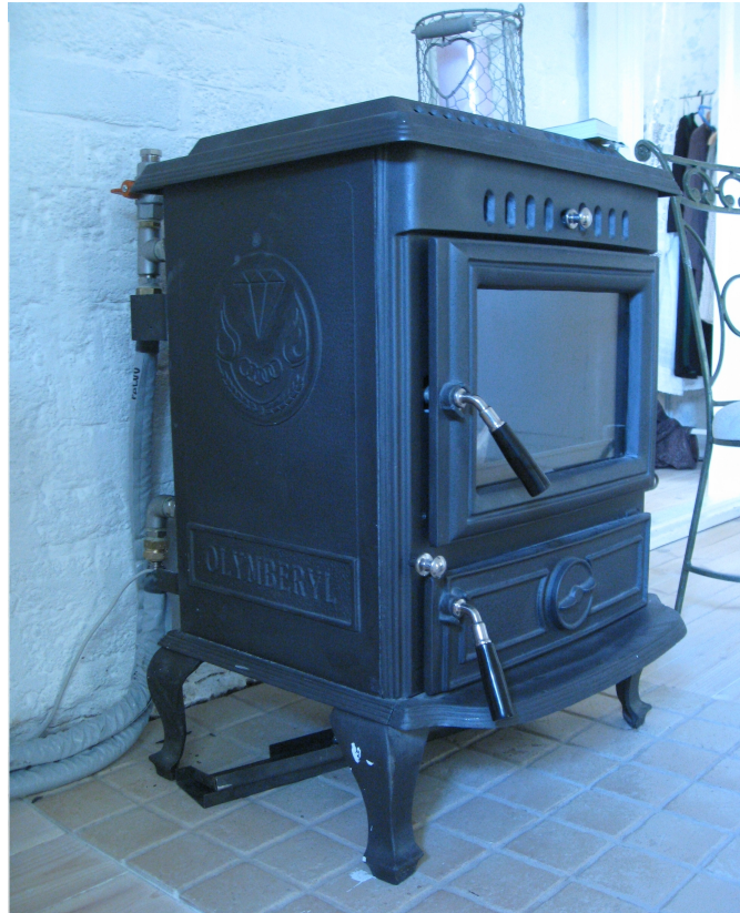
Kuva 4.3: Esimerkkikohteen kamina ja tämän takana vasemmalla lämmitysjärjestelmän tulo- ja paluuputket
