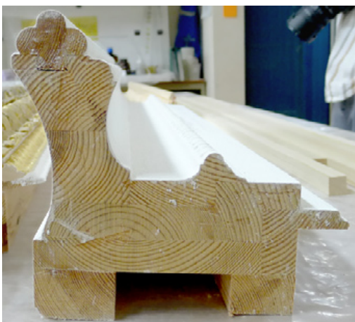
Kuva 5. Tämän modernin muotolistan runko koostuu vanhoja listoja useammasta osasta. Pinnalla on ohut pohjustus.
