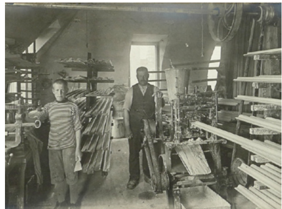
Kuva 13. Muotolistoja pohjustetaan koneellisesti Strindbergin kehysverstaassa. Kuvälähde: Petteri Viljakainen.
