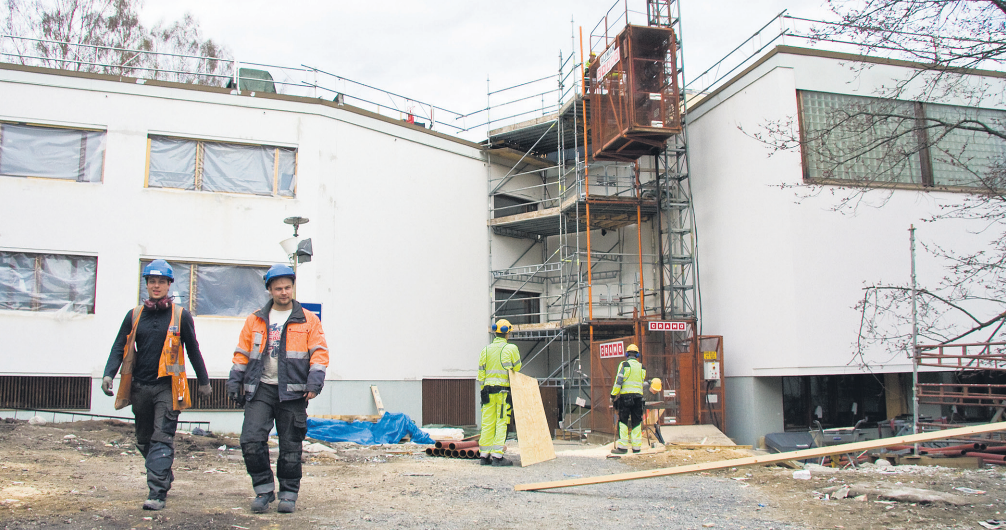
Alvar Aallon suunnittelema vuonna 1971 valmistunut Liikunta-rakennus meni remonttiin keväällä 2011. Remontin pitäisi valmistua syksyksi.
