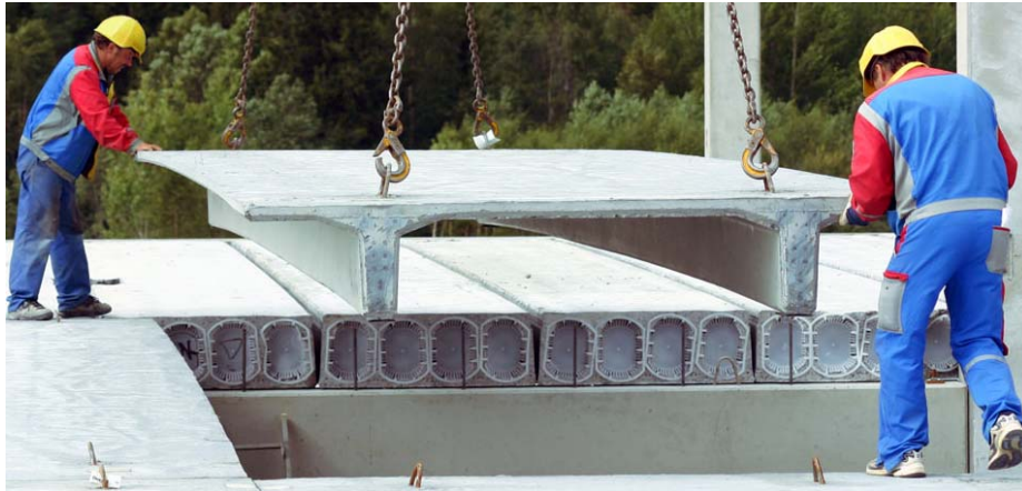
Kuva 3: TT-laatan asennusta välipohjaan (www.betset.fi)
