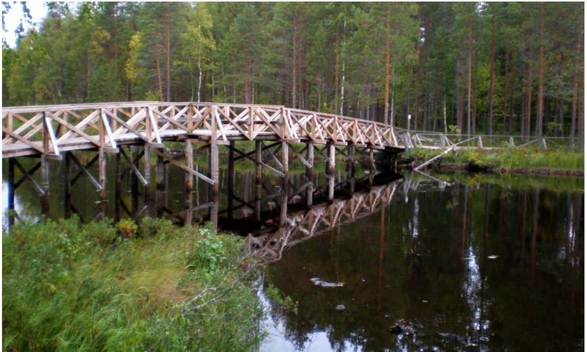
KUVA 17. Katiskalahden ylittää komea talkoovoimin rakennettu silta.
