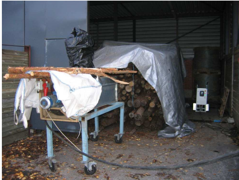
Kuva 26: Ylivuotista puuta kuivattiin lisää lämpöpuhaltimen avulla. Kasa peitettiin pressulla ja puhaltimella puhallettiin lämmintä ilmaa pinoon.
