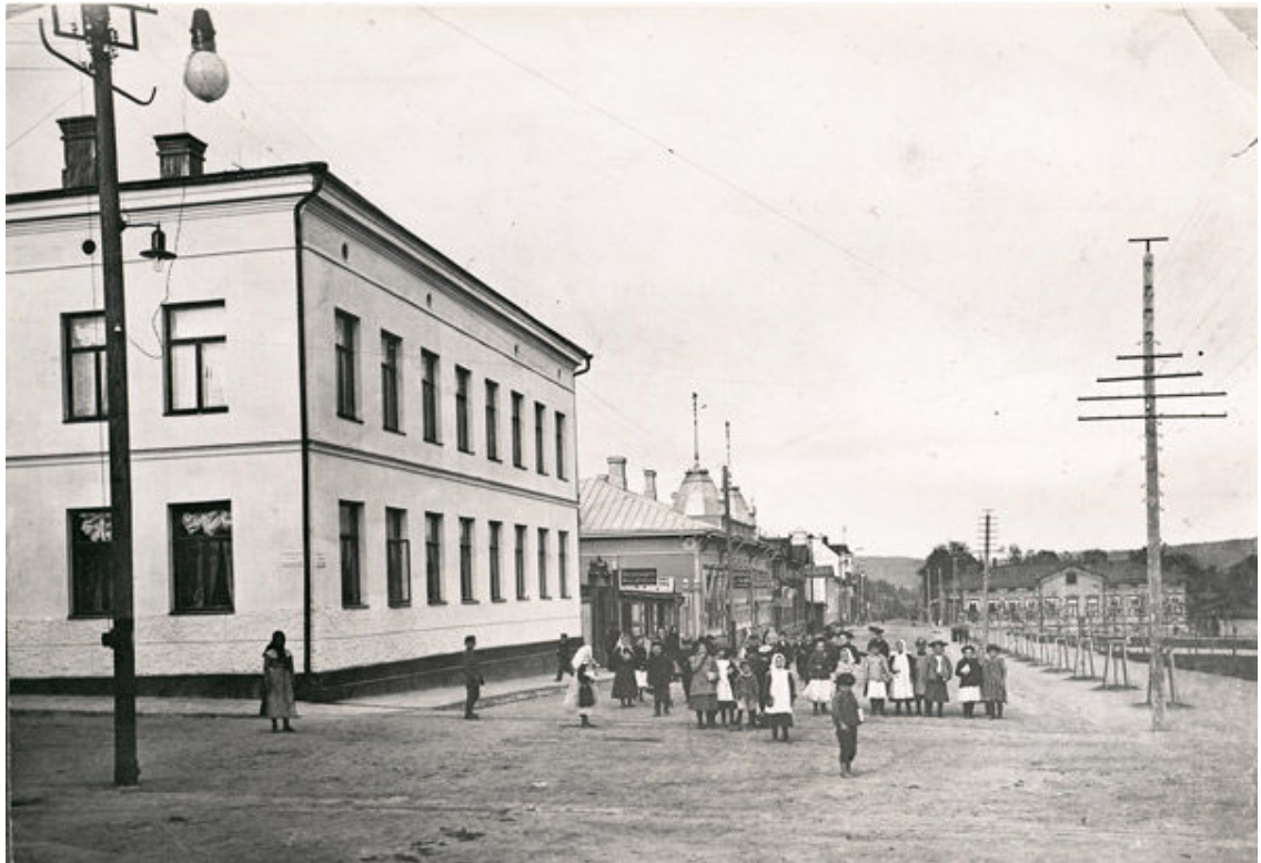
Kuva 10. Kauppakadun ja Läntisen torikadun, nykyisen Gummeruksenkadun, risteykseen on sijoitettu yksi Jyväskylän ensimmäiseen katuvalaistukseen kuuluva valaisinpylväs. Pylvään alaosassa näkyy kaarilamppukuvun alas laskemista ja sytyttämistä varten rakennettu vinssi-mekanismi, jonka salvan avulla lamppu voidaan lukita sopivalle korkeudelle, yläosassa näkyy mekaniisin vaijereita. Kaarikuvun alapuolella Nernst-lamppu. Kuva Keski-Suomen museo.
