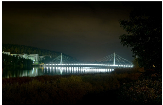
Kuva 2. Mattilanniemen vuoden 2008 syksyllä valaistu kävelysilta. Valaistussuunnittelija Annukka Larsen. Kuva Jyväskylän kaupunki/Juhana Konttinen.
