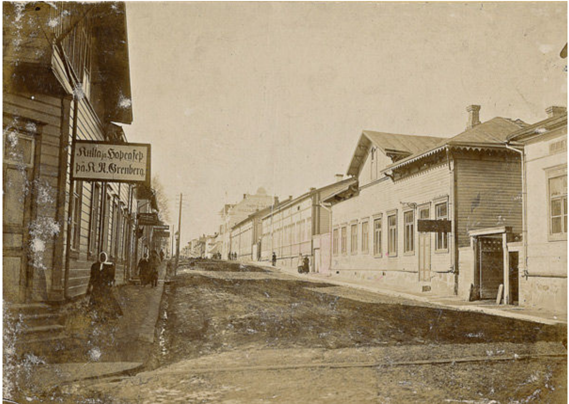
Kuva 9. Liike-elämään keskittyneessä Kauppakadun alapäässä, "alakaupungilla", on 1800–1900 -lukujen vaihteessa harvakseltaan ensimmäiseen julkiseen katuvalaistukseen kuuluvia matalia öljylyhtypylväitä; ks. vasen kadunvierus puhelinpylvään kohdalla. Kuvan ottoajaksi tosin arvioidaan 1910–1930 -lukuja. Kuva Keski-Suomen museo.
