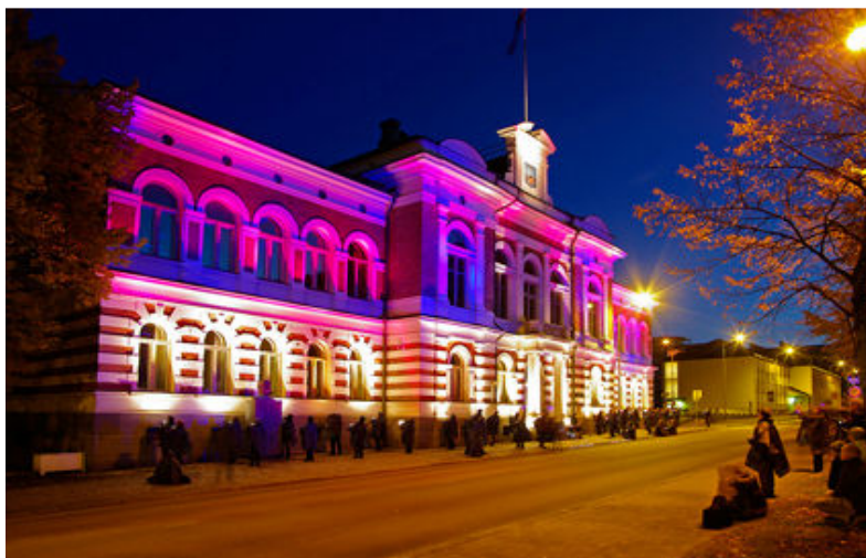
Kuva 7. Jyväskylän kaupungintalo käsi-valaisimilla valaistuna 30.9.2008 Guerrilla Lighting -tempauksessa. Valaistussuunnittelu Antti Hiltunen ja Juho Strömmer. Kuva Jyväskylän kaupunki/Juhana Konttinen.
