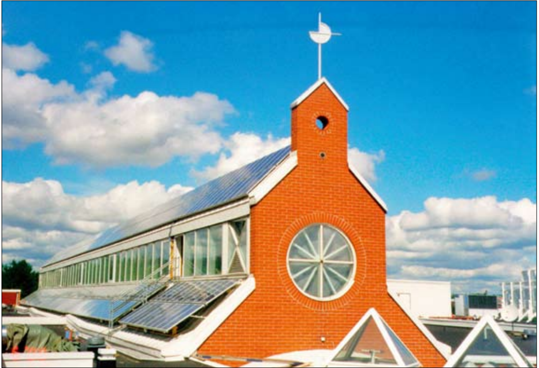
Lielahdessa sijaitsevan Citymarketin aurinkosähköjärjestelmä on vielä toistaiseksi Suomen suurin. Sen nimellisteho on 39 kW. Naps Systems rakensi järjestelmän vuonna 2000.
