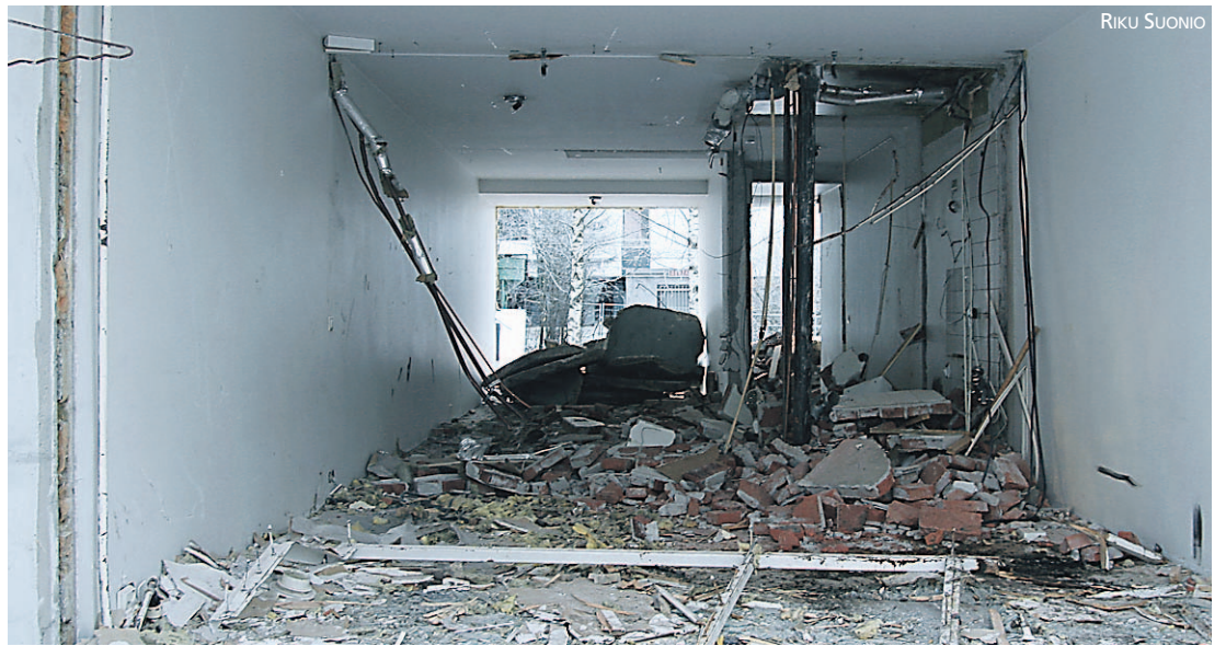
Huonon kunnan vuoksi purettavia G- ja F-taloja ei voi kohta enää rakennuksiksi sanoa.
