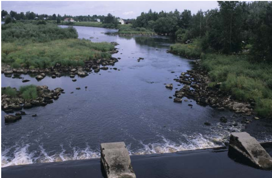
Kuva 4. Reinilänkosken patorakennetta (kuva Unto Tapio).
