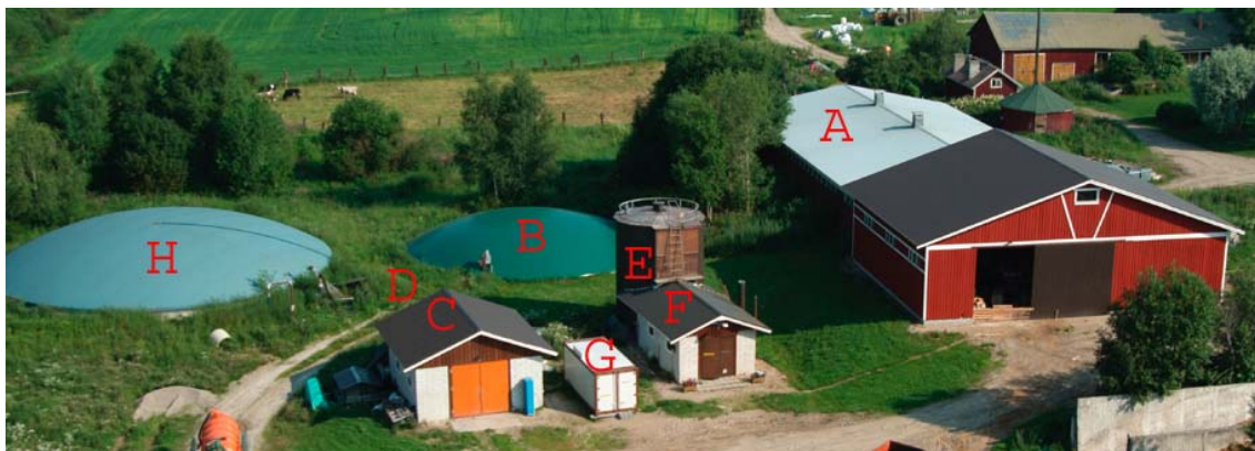
Kuva 7.8. Monituotantolaitos Kalmarin maatilalla Laukaassa. Siellä valmistetaan liikennepolttoainetta (metaani), sähköä, lämpöä ja lannoitteita yhteismädätyksellä lannasta, teollisuusjätteistä, kasvijätteistä, ruokajätteistä ja energiakasveista. (Lampinen 2004b) [Lauri Jokela 2004]
