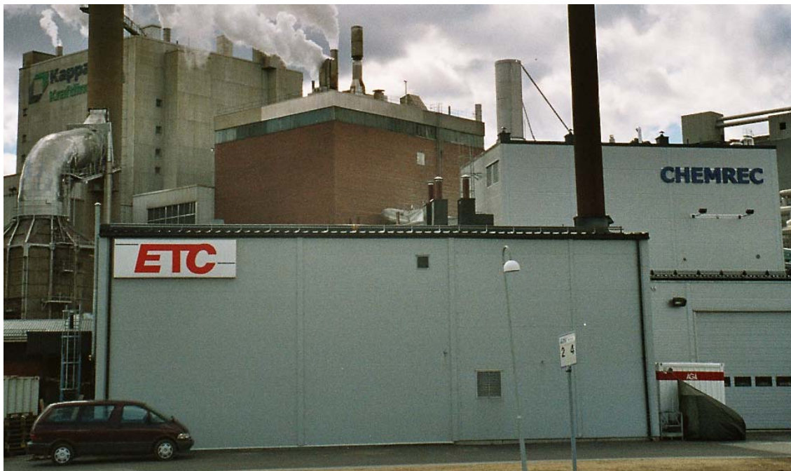
Kuva 5.9. Mustalipeän kaasutukseen perustuva liikennepolttoaineiden, erityisesti metanoli ja DME, tuotannon 3 MW:n demonstraatiolaitos sellutehtaan yhteydessä Piteåssa Ruotsissa. [2005]
