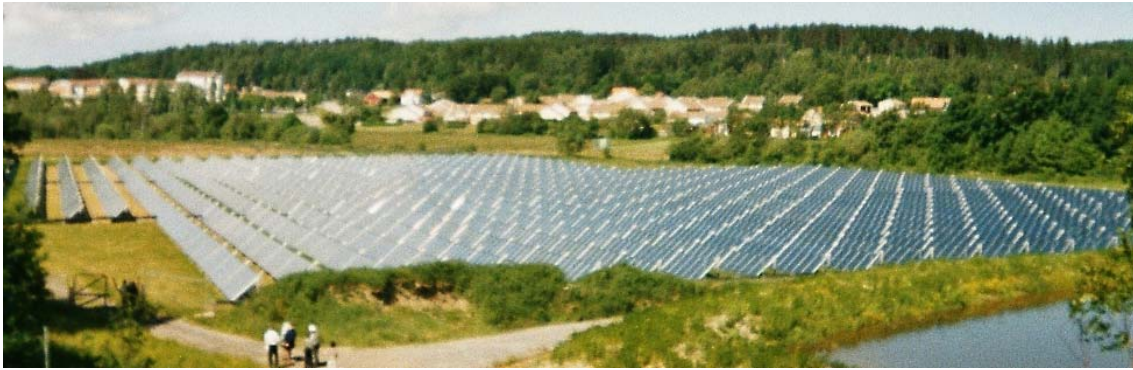
Kuva 2.2. Yhden hehtaarin (10.000 m 2 ) tehollisen alan aurinkokeräinkenttä pellolla Kungälvissä Göteborgin pohjoispuolella Ruotsissa. Se tuottaa paikalliseen kaukolämpöverkkoon hyödynnettävää lämpöenergiaa yhtä paljon kuin 100 hehtaaria energiakasviviljelystä. Koska keräimet on suunnattu kaltevasti etelään, jalustojen maapinta-alan tarve on prosenttien luokkaa keräinkentän pinta-alasta ja muu osa jää matalakasvuisen niittyekosysteemin käyttöön. Kenttää käytetään lampaiden laidunmaana, jolloin keräimet toimivat suojana sekä auringolta että sateelta. Kaukolämpöverkon päälämmityslähde on hake. [2003]
