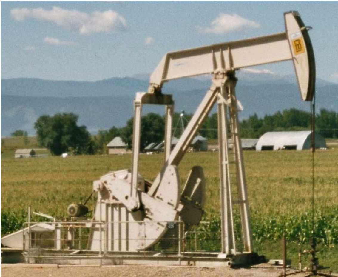
Kuva 1.2. Maatilakohtainen raakaöljyn pumppausasema Wyomingissä USA:ssa [2004].
