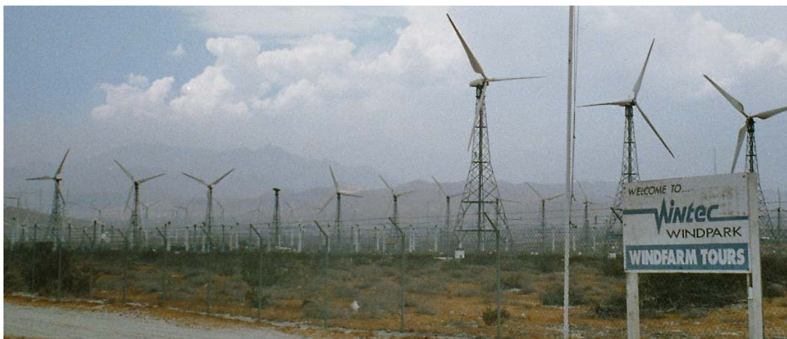
Kuva 2.12. Yli 3000 tuuliturbiinin puisto laidunmaalla Palm Springsissä Kaliforniassa. Tämä pääosin 1980-luvulla rakennettu, Kalifornian kolmanneksi suurin tuulipuisto koostuu keskimäärin 100 kW:n turbiineista. Se on myös huomattava turistinähtävyys. [2004]
