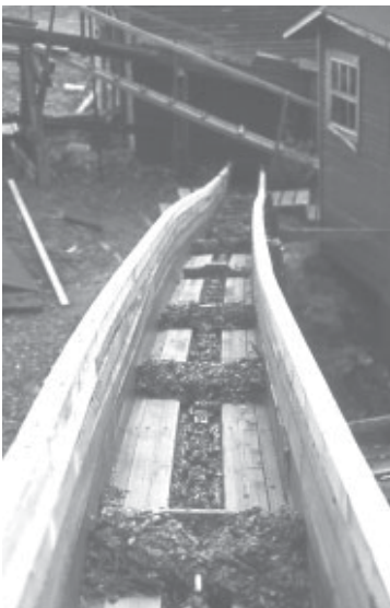
Kuorimon kuljetin vie kuoret kasoihin.
