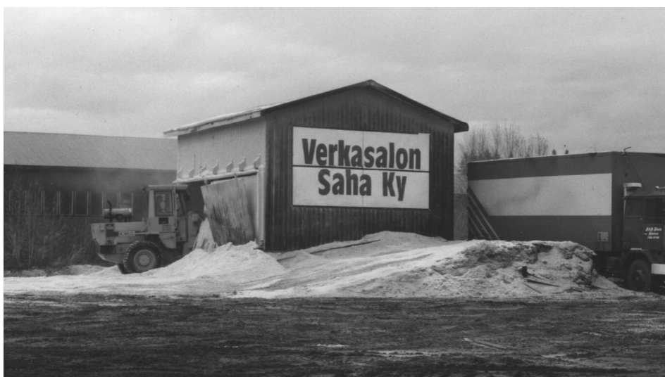
KUVA 1 Sahan julkisivu vuonna 1992.
