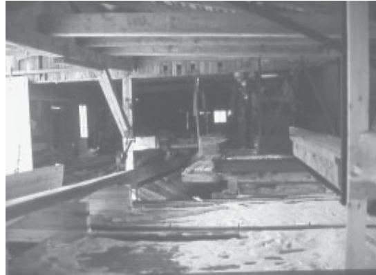
Tasauspöydällä katkotaan lankut ja laudanpäät tasaisiksi
