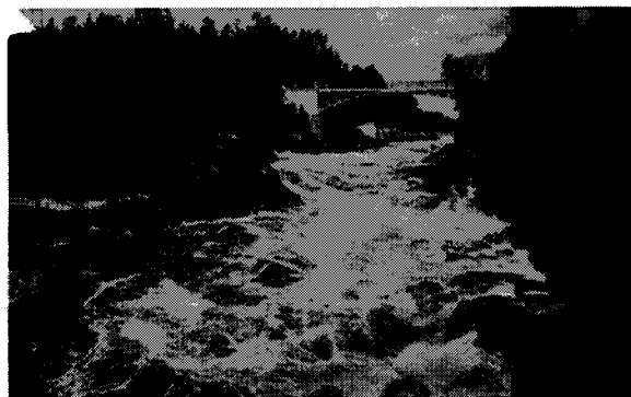
Vuonna 1892 rakennettu silta kuvattuna kosken alajuoksulta.
