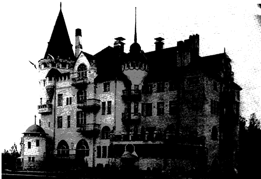
Kuva 3: Valtionhotellin pohjois- ja länsifasadi luoteesta. Valok. Nyblin. (Lilius 1983b, s. 51)
