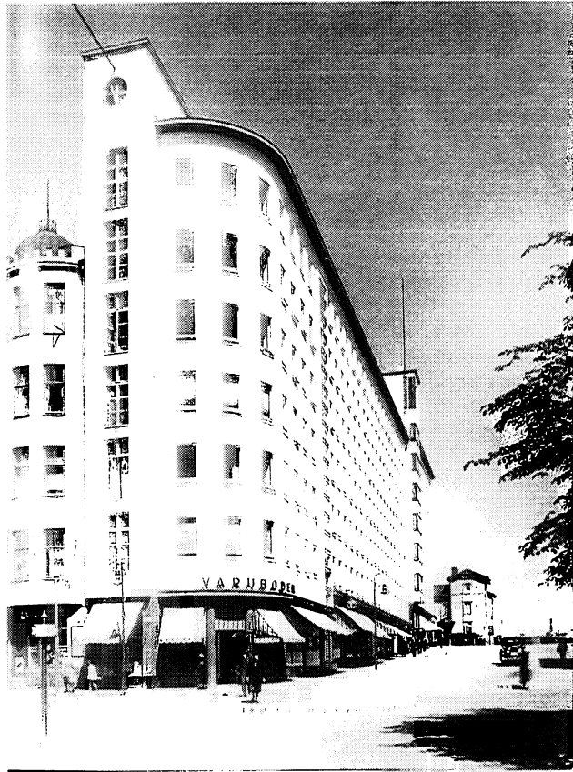
34. M. Välikangas, As. Oy Artturinlinna, 1932, Helsinki. Keinänen 1993, 52.
