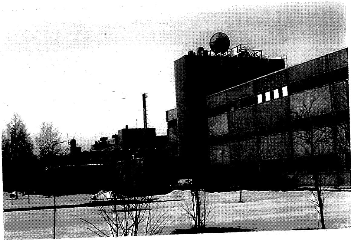
KUVA 8. Itäinen julkisivu (valok. J.Vuorinen).
