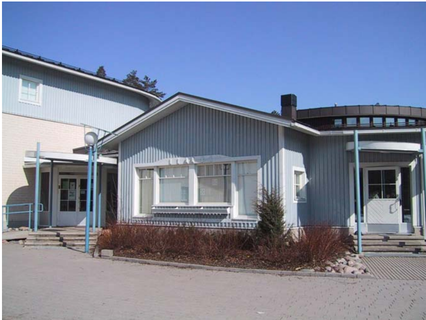
Kuva 2. Vasemmalla pääovi ja oikealla luokkien välinen ovi.
