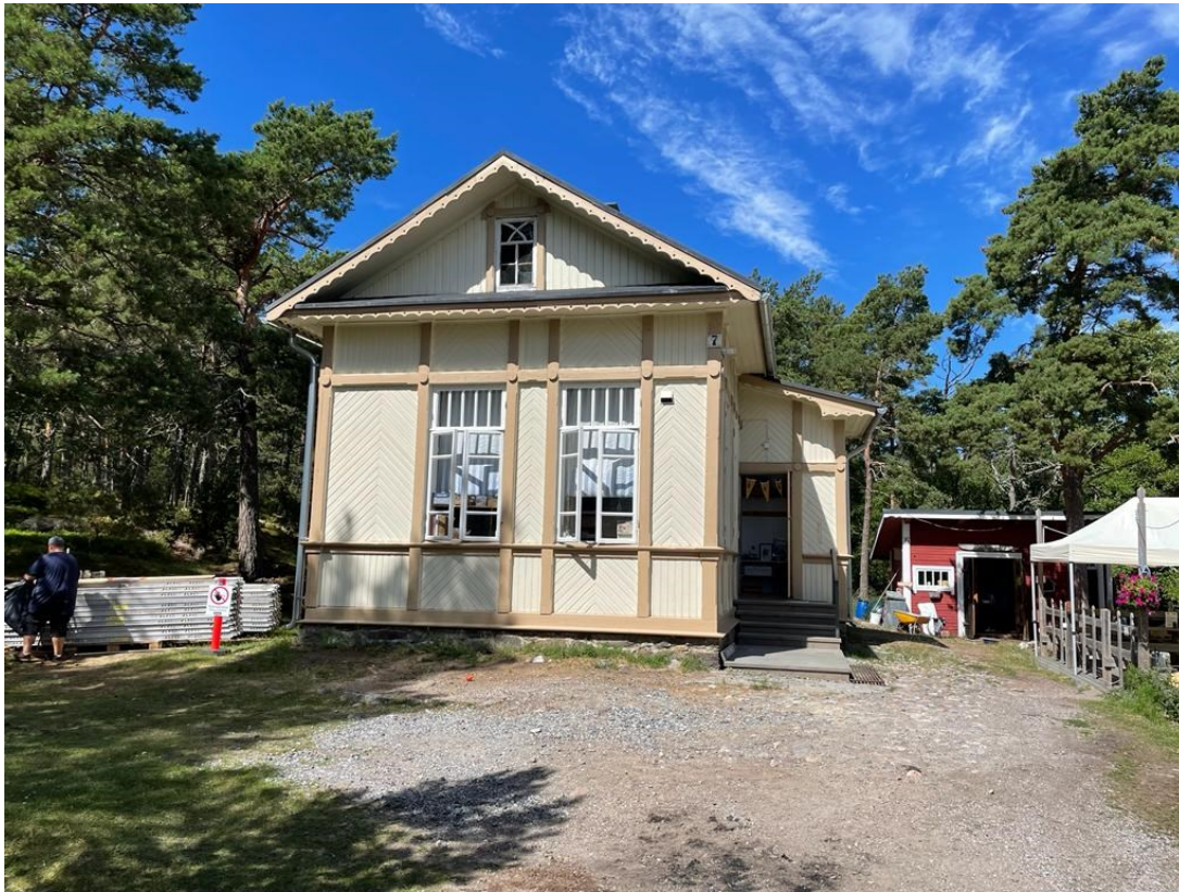
Kuva 48 Santarmintalon korjaushanke, korjaus valmistumassa (kuva Vihka Oy 2022)
