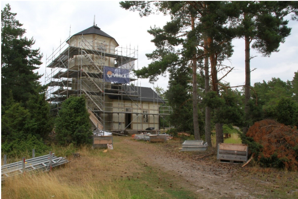
Kuva 51 Vesitornin korjaushanke, telineet (kuva Hilja Palviainen 2022)
