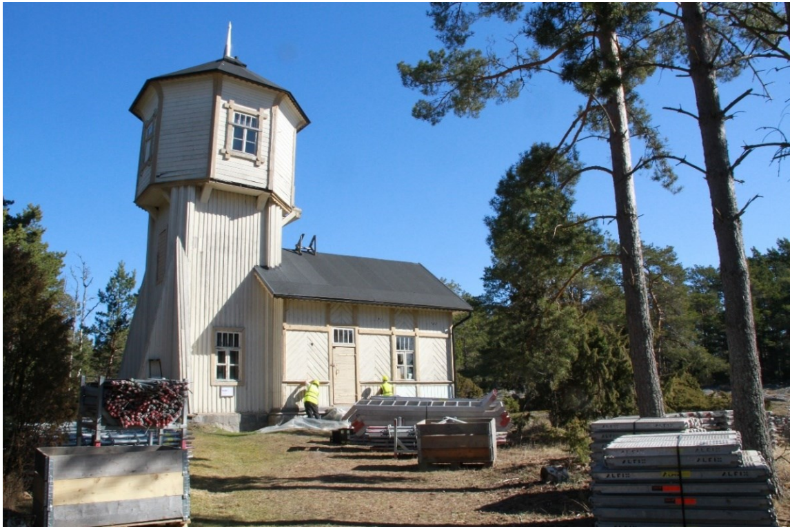
Kuva 52 Vesitornin korjaushanke, hanke loppusuoralla (kuva Hilja Palviainen 2022)
