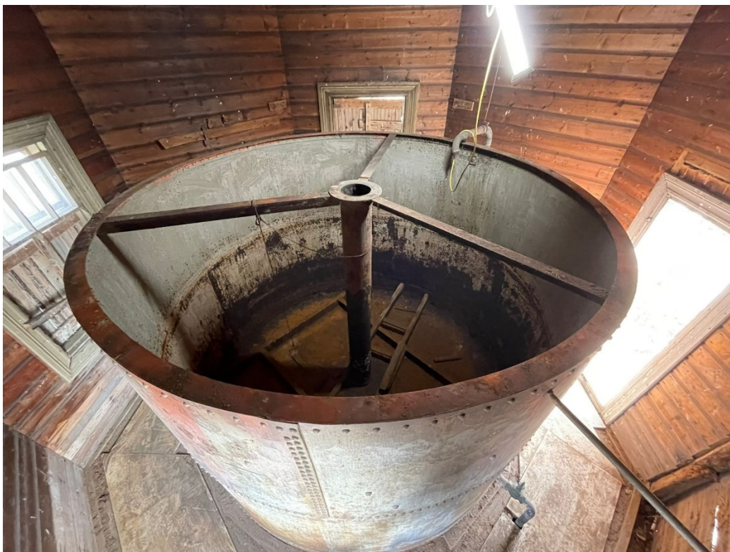
Kuva 49 Vesitornin korjaushanke, tornin sisällä ollut terässäiliö (kuva Vihka Oy 2022)
