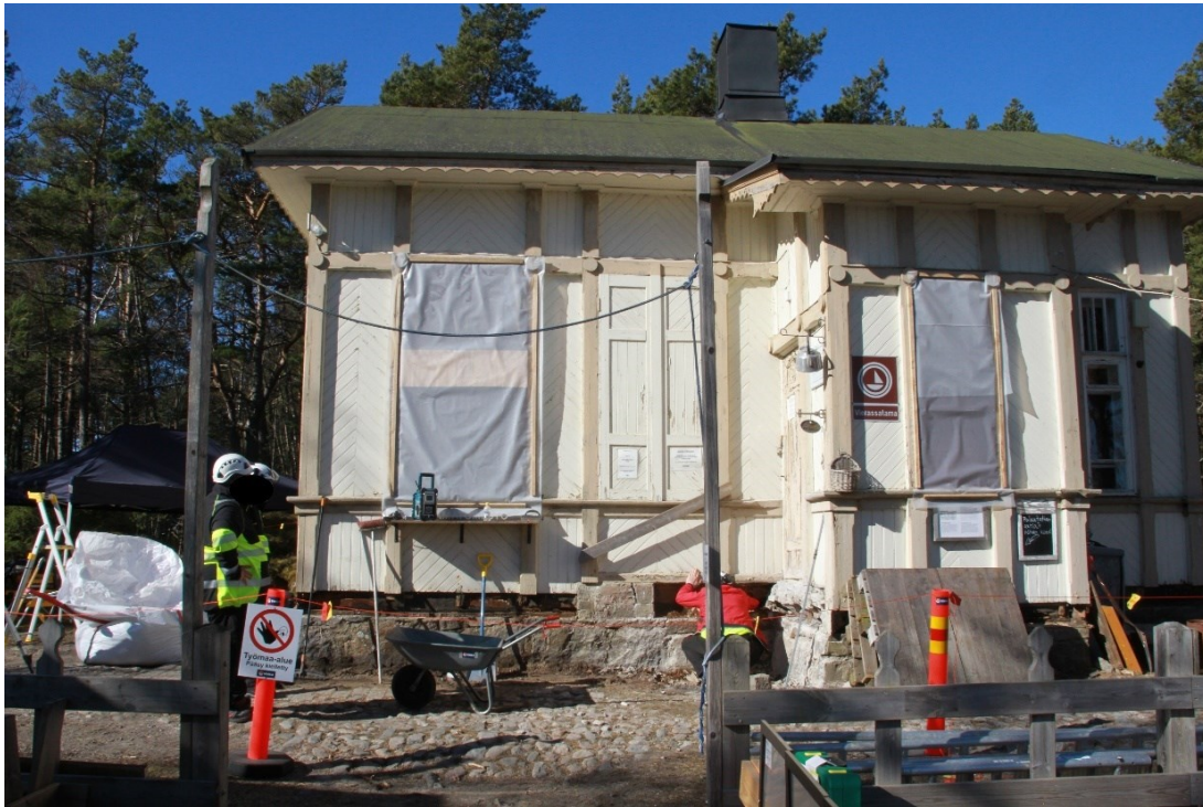
Kuva 46 Santarmintalon korjaushanke, kuva työmaavaiheesta, betoniporras on purettu (kuva Hilja Palviainen 2022)
