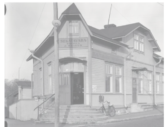
Sekatavarakauppa J. Heiton liikerakennus Valtakadun varressa. Kuva: Mauno Mannelin. Etelä-Karjalan museo.
