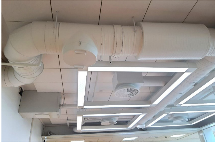
Kuva 10: Kattorakenteita. Arto Sipinen & Ari Sipinen, Kirjasto Lähde, 2022, Jyväskylä. Kuva: Ida Kokko
