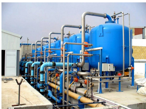
Teollisuudessa säiliöt valmistetaan teräksestä ja niiden sisällä on kovakumipinnoite. 33
