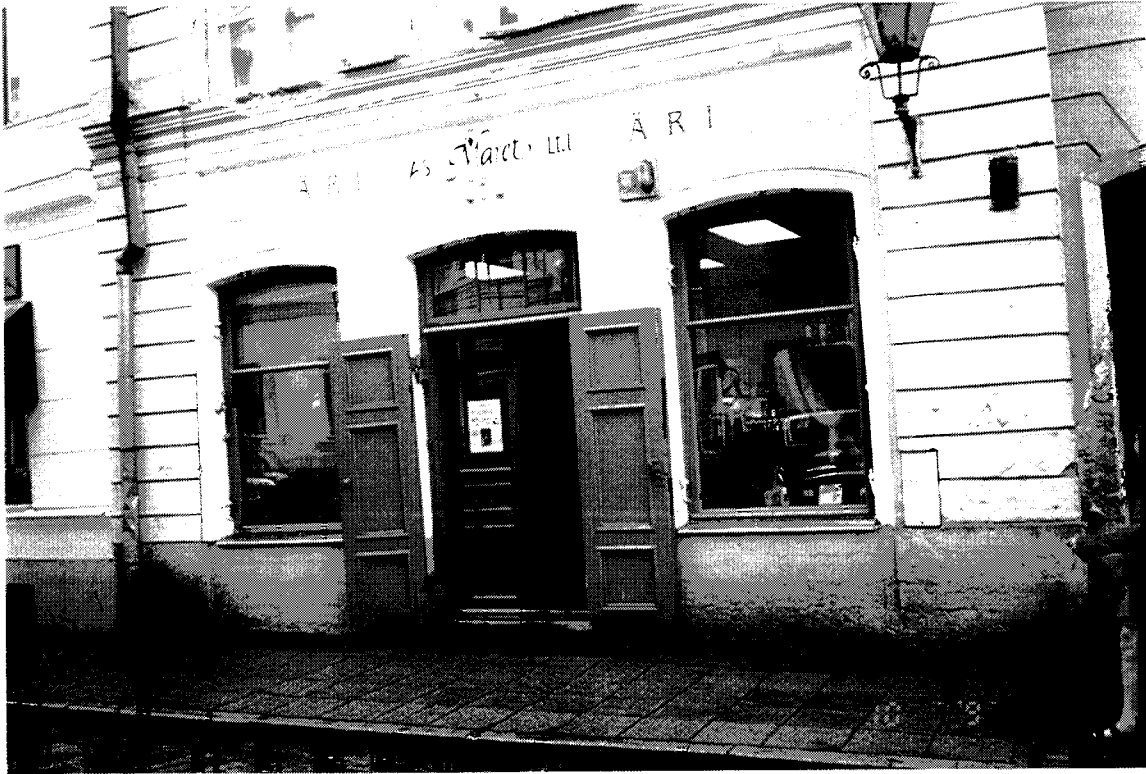
Kuva 8. Neuvostoaikana rakennukset pääsivät huonoon kuntoon. Kuva Arja Kohvakka-Viinanen 1997.
