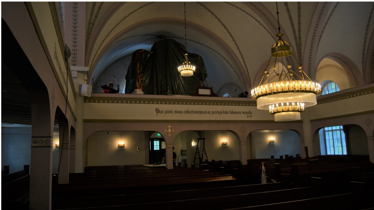
Kuva 16. Hartolan kirkkosali 2013 korjaustöiden ajalta: wc-tila ja varasto jo rakennettuina. 5.9.2013. Kuvaaja Vesa Järvinen. Itä-Hämeen museon kokoelma. Hartola.
