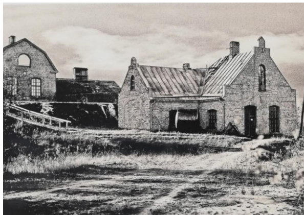
Kokkolan historia V:n mukaan kuvassa on vanha vesilaitos 1923–1943. Rakennukset sopisivat kuvailun mukaan olemaan Åkermanin piirtämät pumpuhuone ja vesisäiliörakennus. Kuva: Kokkolan kaupungin historia V, Juha Saaren arkisto.
