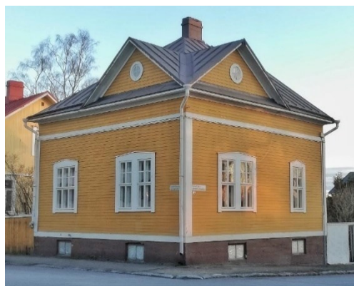
Vesitorninkatu 5 vuonna 2020. Kuva: AKP.
