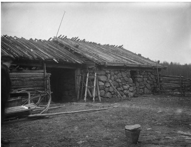
Rytkönen, A. Huosiaismäen malkakattoiset kivinavetta ja hirsinen navettalato, joita erottaa avonainen välikkö. 1920-1929. Kansatieteen kuvakokoelma. Museovirasto.
